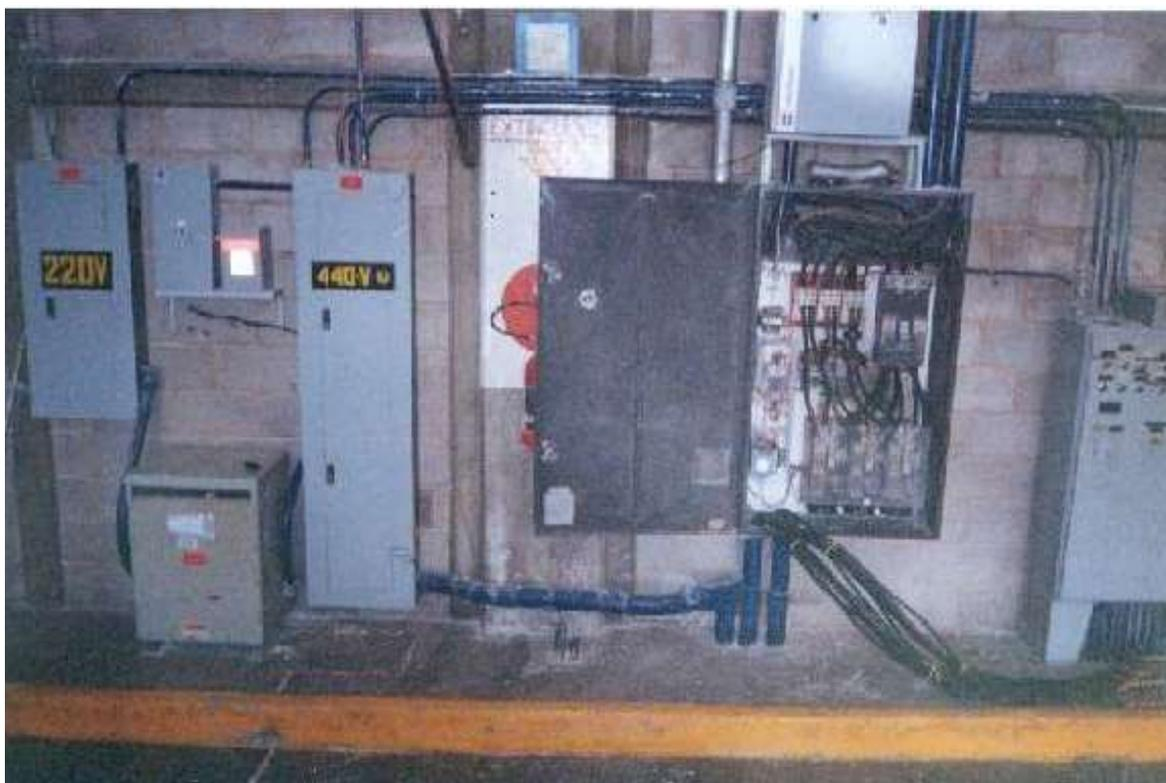
**Figura 2.4** Centros de carga y tableros de control.
