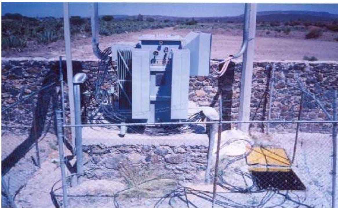
**Figura 2.3** Transformador de potencia y derivación de alimentadores.
