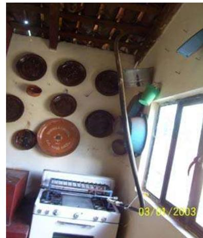
Fig. 6.6 estufa alimentada con biogas
