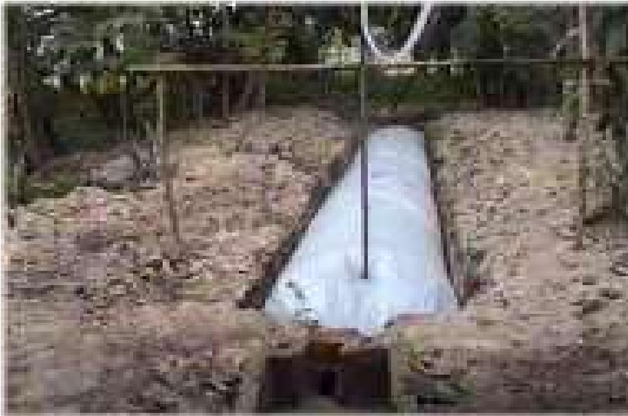
**Fig. 3.1 Biodigestor de polietileno**
