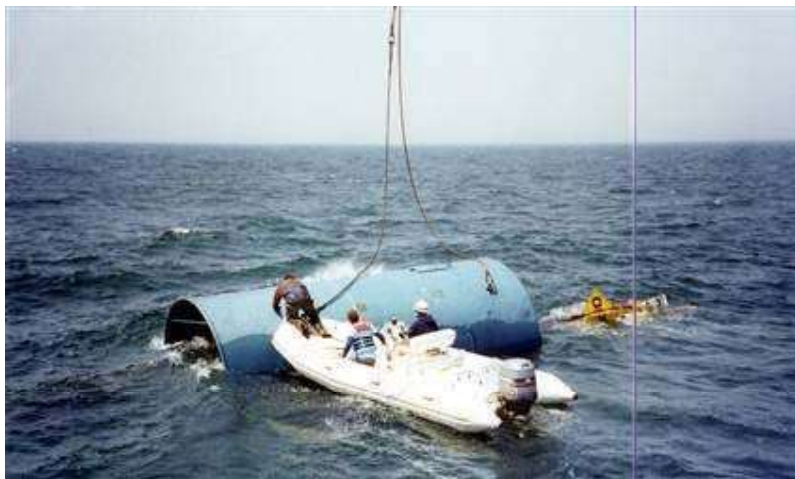
Figura 4.2 Muestra la colocación de un prototipo para aprovechar el salto de olas
