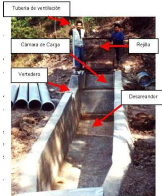
Figura 4.6 Cámara de carga.
