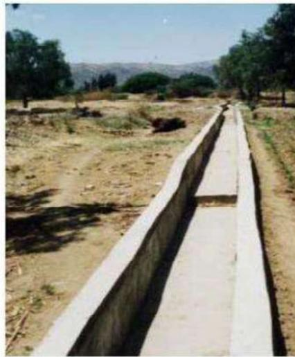
Figura 4.4 Canal en forma rectangular de hormigón.
