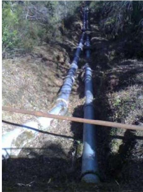
Figura 4.7 Tubería de presión de 55cm de diámetro.
