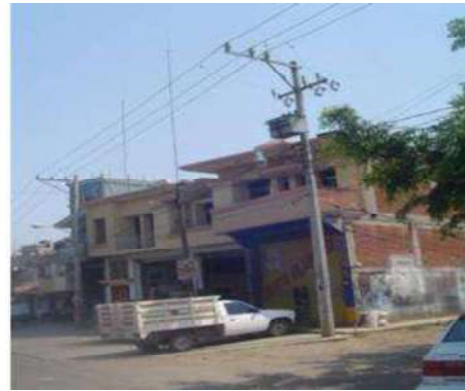
Figura 1.2.- La fotografía de la izquierda muestra una zona arbolada sobre el paso de red eléctrica con conductor desnudo, mientras que en la fotografía de la derecha se observan conductores muy cercanos a las partes altas de las viviendas, lo cual representa un peligro para los usuarios.
