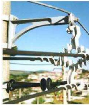
Figura 3.15.- Colocación y función del herraje tipo L.
