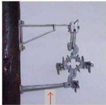
Figura 3.9.- Función e instalación del brazo antibalanceo en el espaciador.
