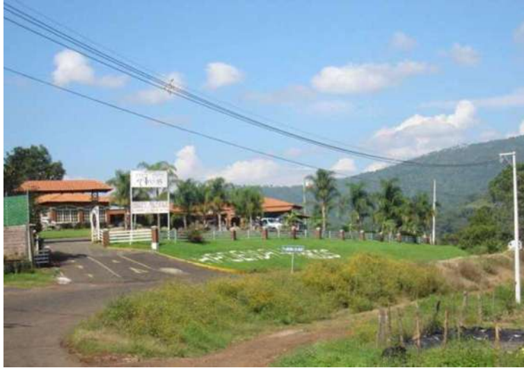
Figura 3.42.- Construcción de 43 km de línea de M.T. a octubre de 2007.
