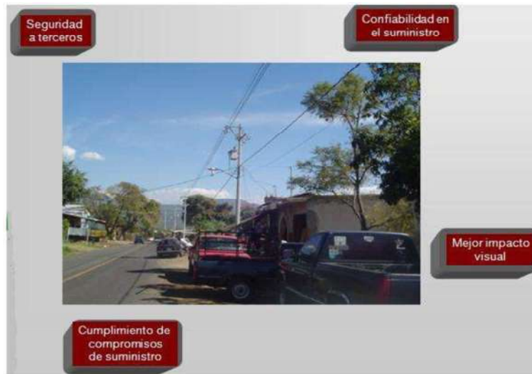
Figura 3.40.- Beneficios obtenidos por el cliente con la construcción de instalaciones compactas.
