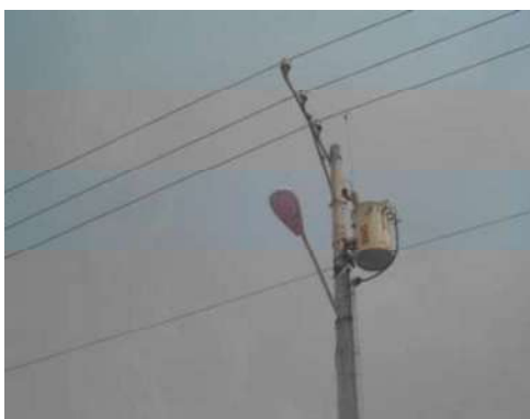
Figura 1.1.- Línea de distribución en M.T. (13.2kV) convencional con conductor desnudo.
