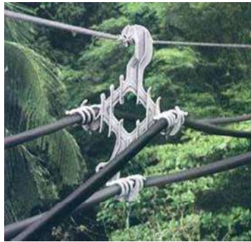
Figura 3.6.- Colocación de los conductores en el espaciador.
