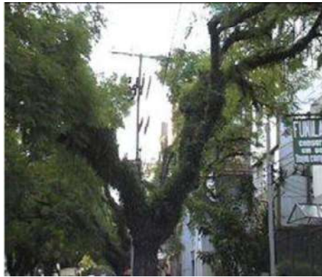
Figura 1.2.- La fotografía de la izquierda muestra una zona arbolada sobre el paso de red eléctrica con conductor desnudo, mientras que en la fotografía de la derecha se observan conductores muy cercanos a las partes altas de las viviendas, lo cual representa un peligro para los usuarios.
