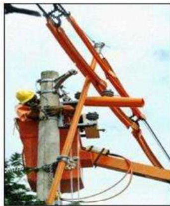
Figura 4.1.- Mayor seguridad para el personal de campo al realizar alguna maniobra.
