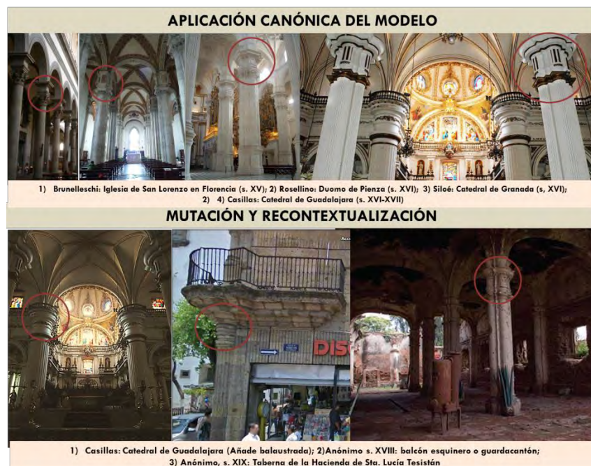
Figura 64: Mutación regional del modelo de interpolación del entablamento entre capiteles y arranque de bóvedas.
