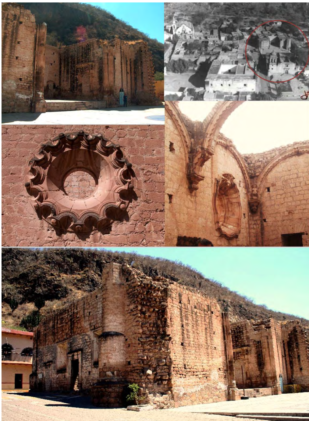
Figura 104: Vista de las obras inconclusas del proyecto de la Nueva parroquia del Real de San José de Bolaños (1778-¿1785?)
