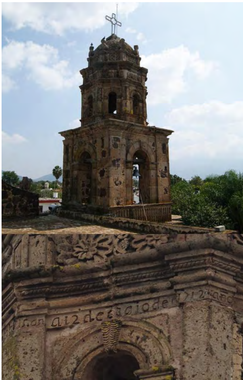
Figura 45: Torre, ubicada en el lado sur del Templo del Hospital de Santa Cruz de las Flores La torre presenta como fecha de conclusión: 12 de mayo de 1712 Fotografía de Elda Bedolla Arroyo, Octubre 2012
