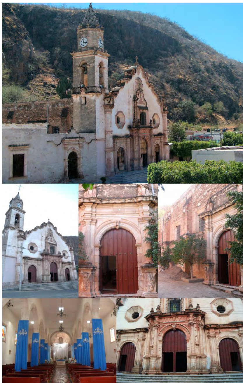
Figura 109: El santuario guadalupano, hoy parroquia de San José de Bolaños (1780-1783) Obra financiada por Antonio Vivanco y cuya construcción es posible atribuirle al maestro alarife José Clemente Elizalde.
