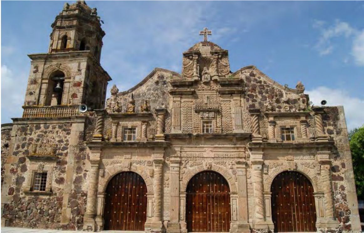
Figura 39: Fachada principal (fachada oriente) del Templo del Hospital de Santa Cruz de las Flores Fotografía de Elda Bedolla Arroyo, Octubre 2012
