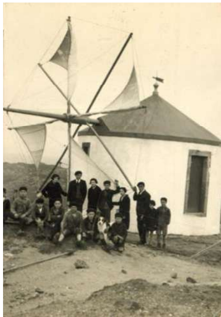
Figura 2.2 Molino de viento en “La Costa de Morte”
