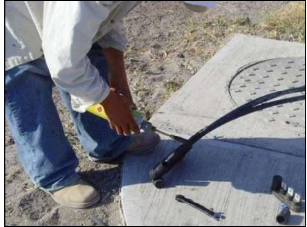
Fig. 6.23 Fundición de manga termocontráctil
