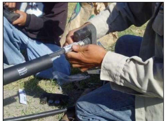
Fig. 6.20 Colocación manga termocontráctil Fig. 6.21 Fijación de zapata al pulpo
