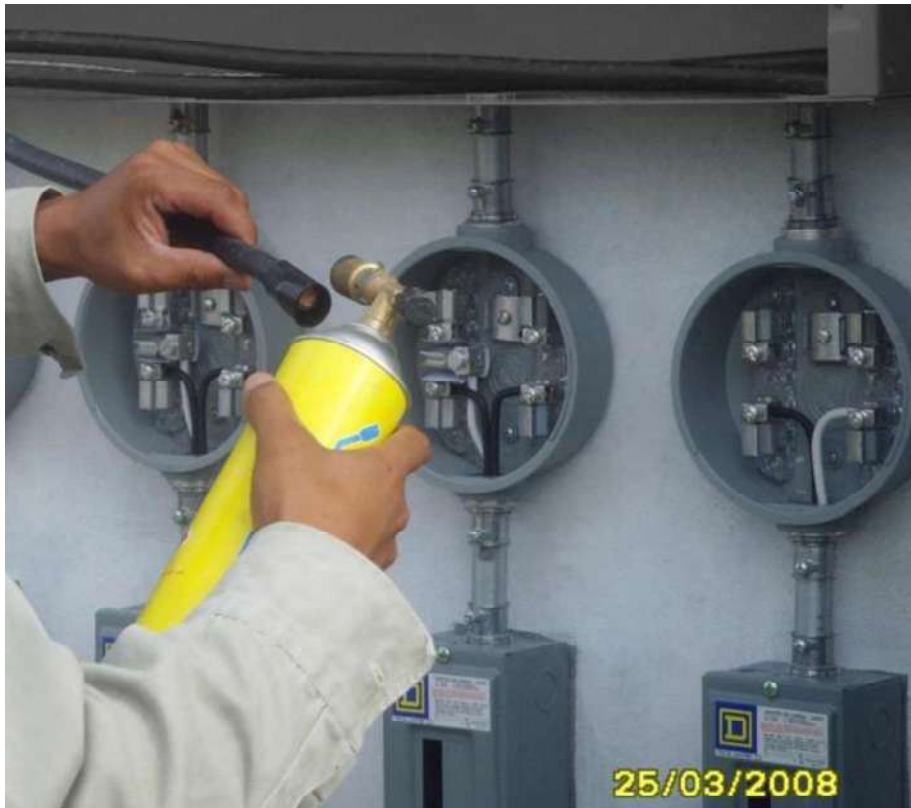
Fig. 6.47 Protección en el extremo final del conductor
