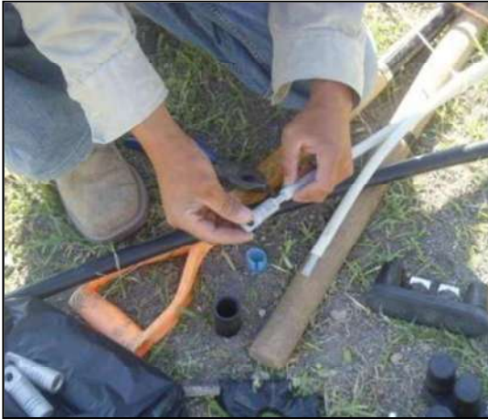
Fig. 6.18 Colocación de zapata en cable Fig. 6.19 Compresión de zapata
