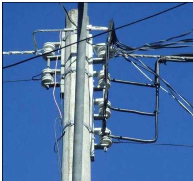
Fig. 2.2 Baja tensión aérea con cable múltiple.
