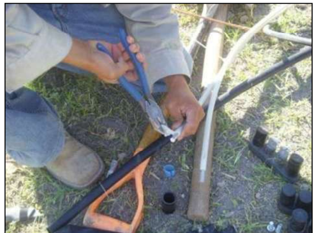
Fig. 6.17 Retiro de aislamiento en cable
