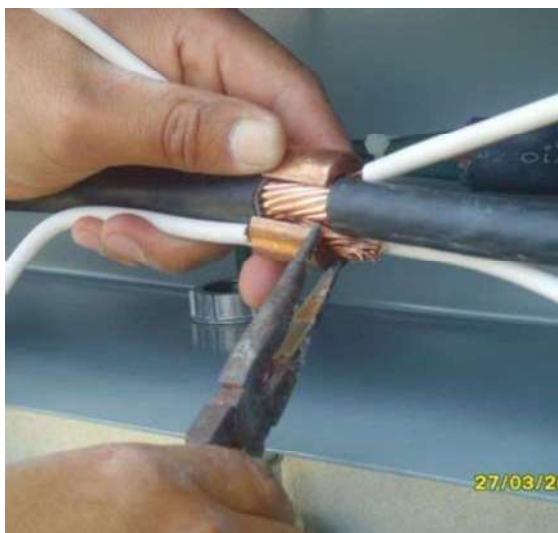
Fig. 6.45 Instalación conector tipo “C”
