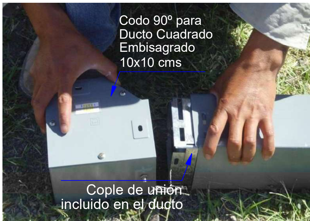
Fig. 6.40 Instalación de codo para cambio de dirección
