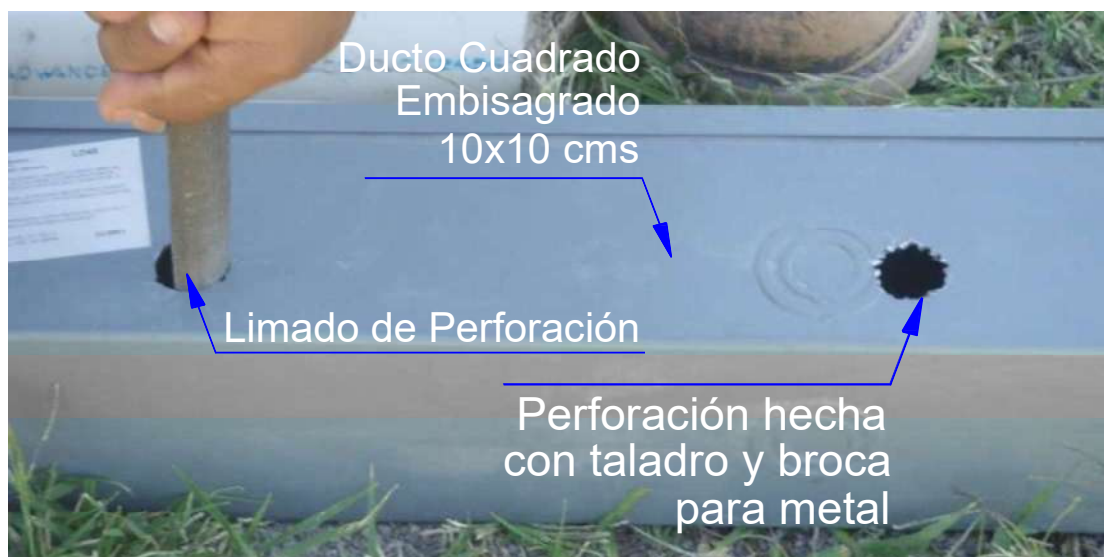
Fig. 6.39 Limado de perforaciones
