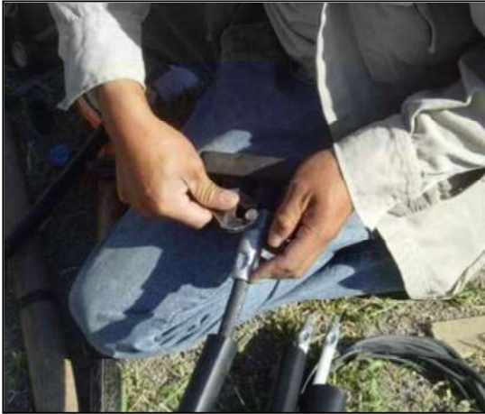
Fig. 6.22 Ajuste de tornillo de fijación
