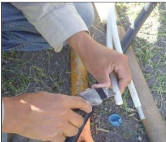
Fig. 6.16 Corte de aislamiento en cable
