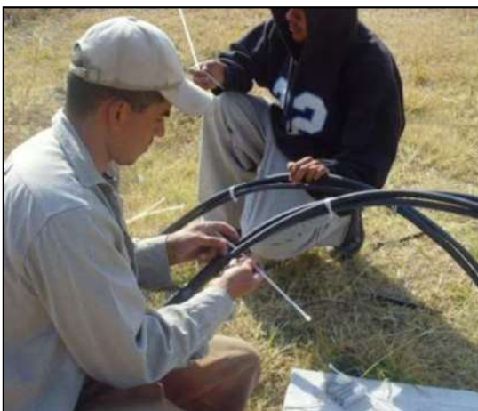
Fig. 6.24 Fijación de placas a conductor
