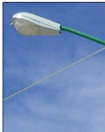
Fig. 3.3 Lámpara OB-15 con brazo de 1.5 mts
