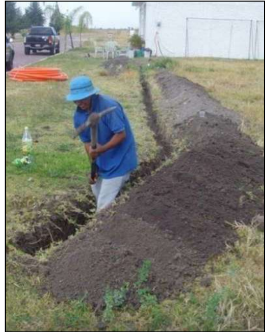
Fig. 6.11 Excavación a mano de ceca
