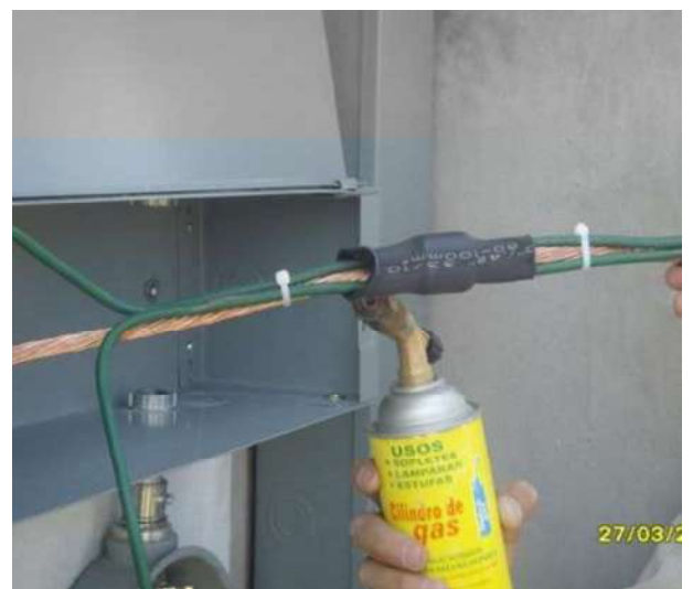
Fig. 6.46 Protección de conexión
