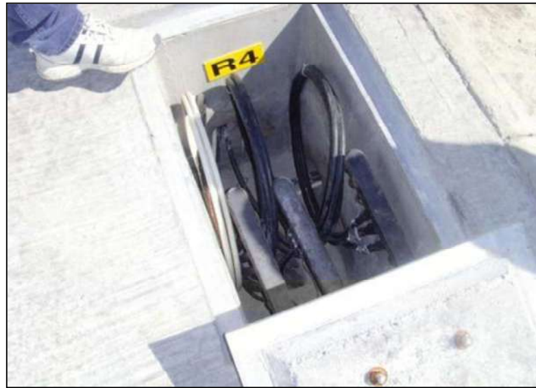
Fig. 6.26 Vista final de un registro terminado revisado por la CFE
