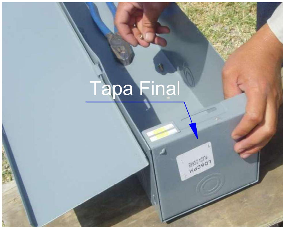
Fig. 6.41 Instalación tapa final
