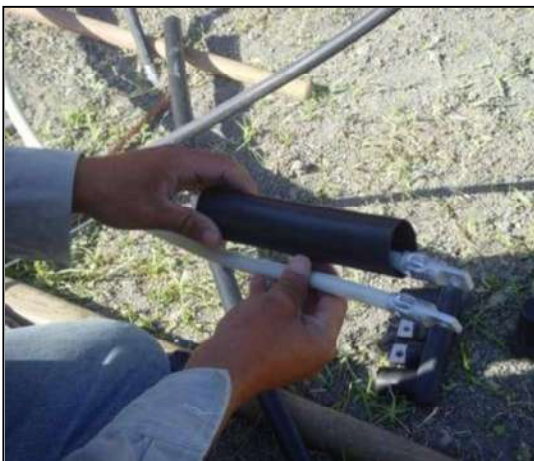
Fig. 6.20 Colocación manga termocontráctil Fig. 6.21 Fijación de zapata al pulpo
