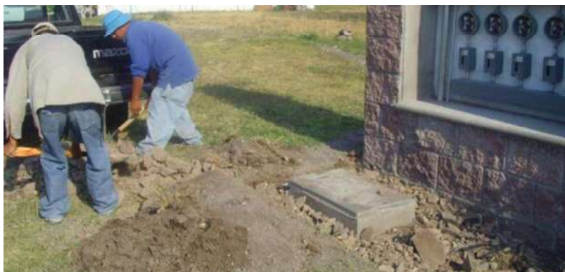
Fig. 6.48 Mejoramiento del terreno
