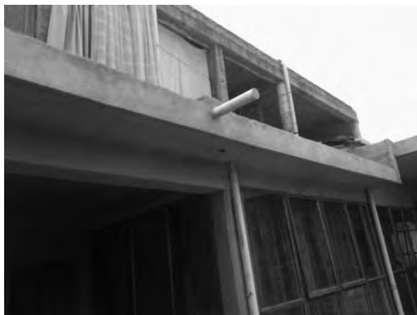
Figura 40. Construcción de cuartos en segundo nivel, acceso delimitado por cortinas, en Tiríndaro. EBA mayo de 2013.
