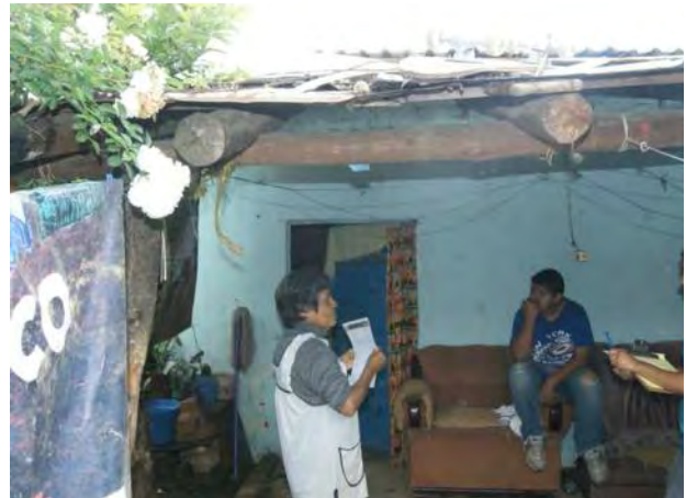
Figura 30. Construcción adicionales, en Tiríndaro. EBA febrero de 2013.
