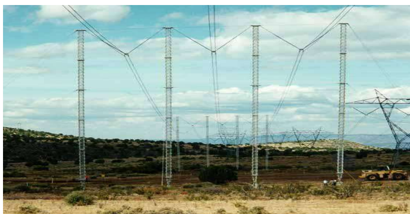
Figura 4.6 Estructura de Cuatro Columnas en Suspensión
