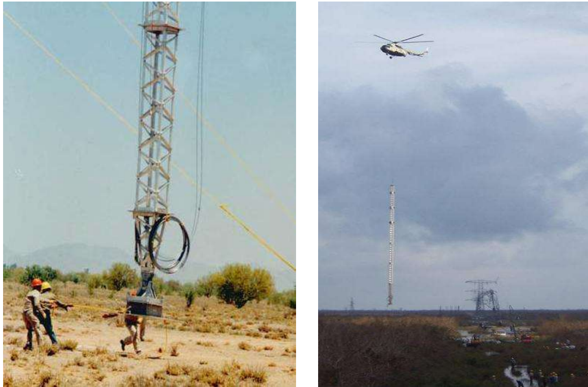
Figura 5.4 Estructura armada en otro sitio, pivoteada y transportada con helicóptero
