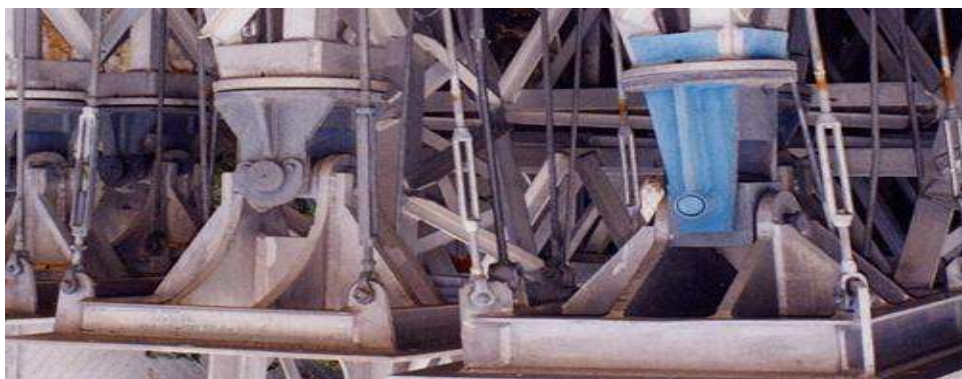
Figura 3.6 Diferencia entre las bases de articulaciones universales Lindsey y Prinex
