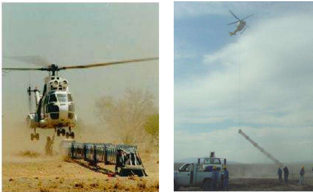
Figura 5.3 Columna pivoteada sobre su base con helicóptero
