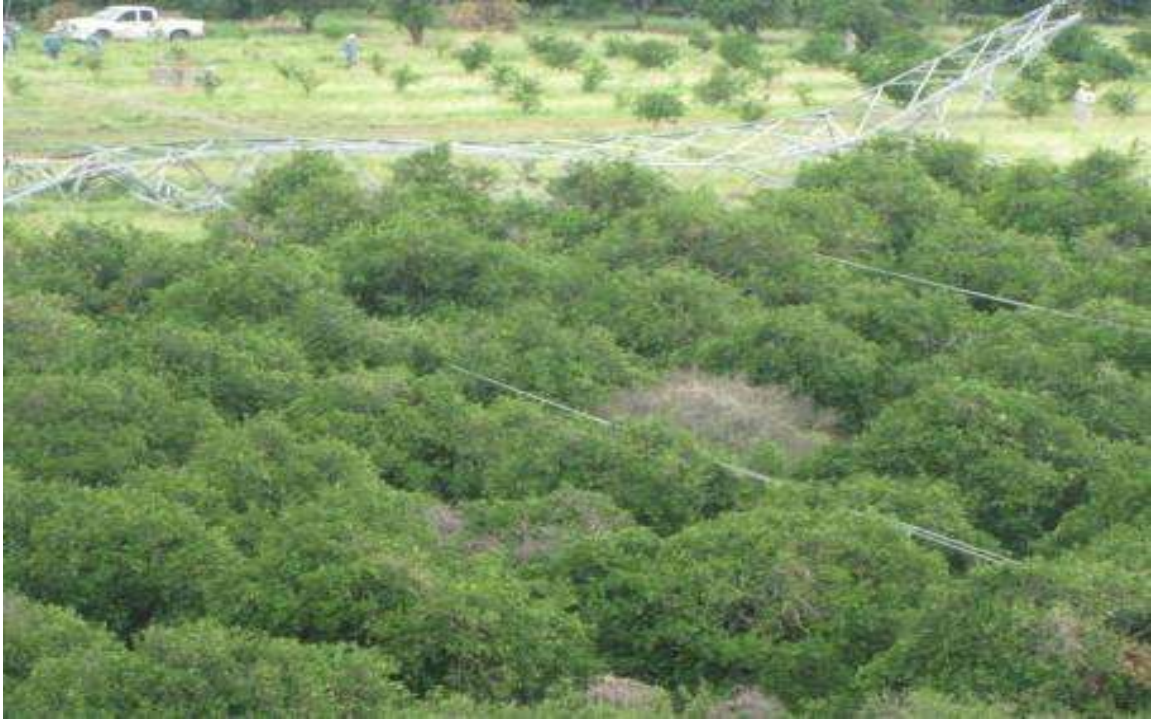
Figura 5.7 Estructura autosoportada colapsada
