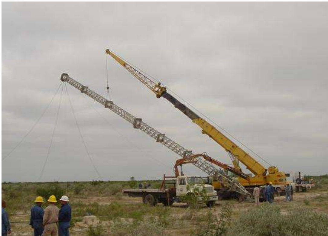
Figura 5.1 Columna pivoteada sobre su base con grúa.
