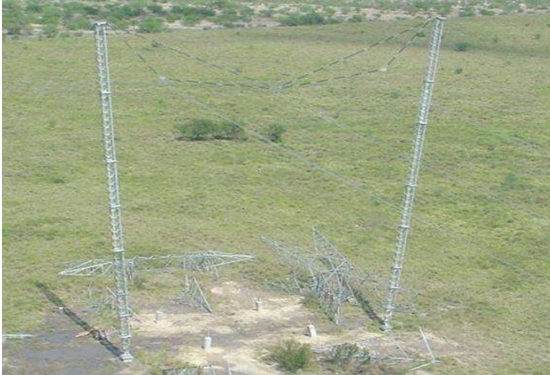
Figura 4.2 Arreglo tipo Chainette
