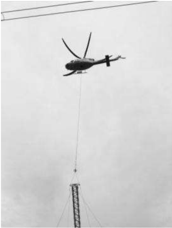
Figura 5.9 Izaje de las columnas de la estructura tipo Chainette mediante la utilización del helicóptero
