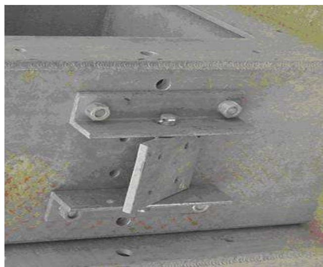
Figura 3.9 Accesorio acoplador para aislador tipo poste (cantiliever)
