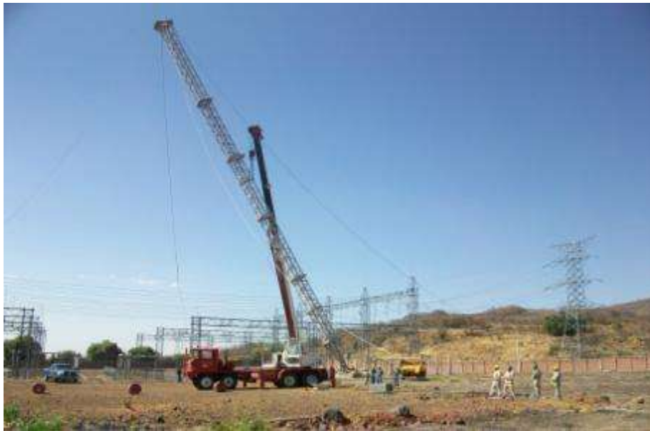
Figura 5.2 Izaje de columna por el método pivoteada con grúa localizando el centro de gravedad
