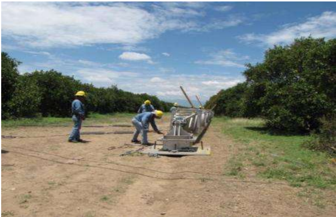
Figura 5.8 Trabajos de armado de las columnas modulares
