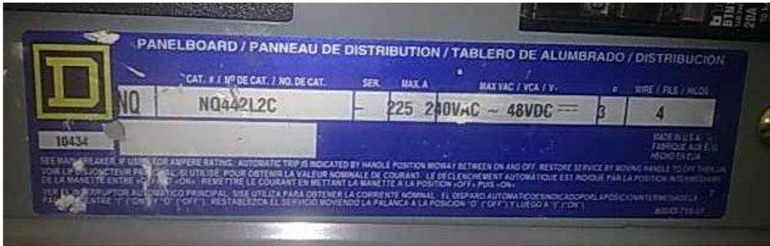
**Figura 4.3** Placa de Datos Tablero de Alumbrado y Distribución.
