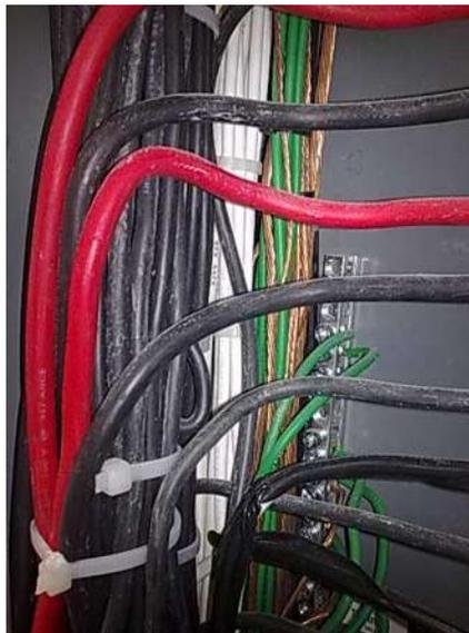
**Figura 4.4** Barra de Tierras de Tablero de Alumbrado y Control.
