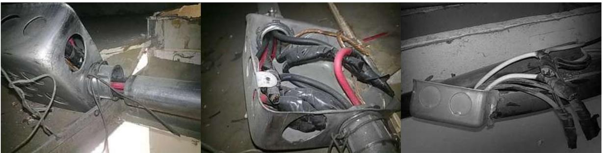
**Figura 4.5** Errores en Canalizaciones.
