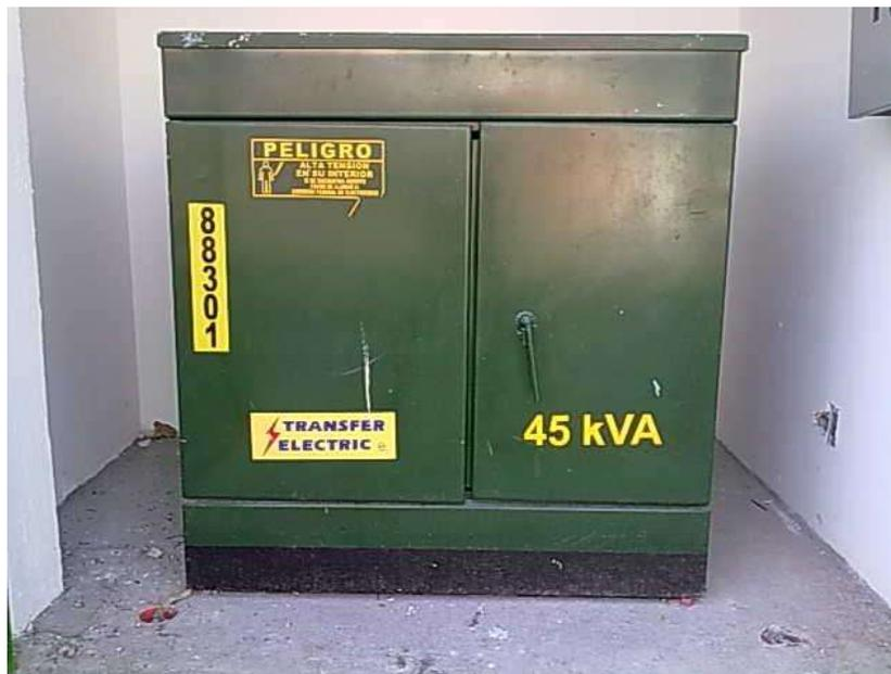
**Figura 4.1** Transformador tipo pedestal instalado en HERBALIFE
