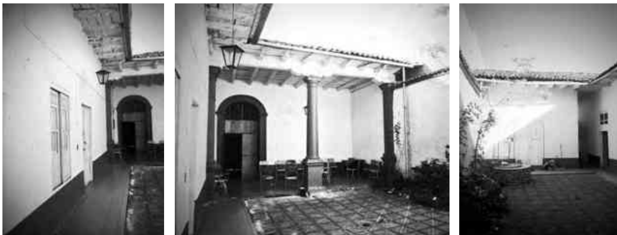
Fig. 36. Fotografías al interior del paitio central de la vivienda Sánchez, espacio rector entorno al cual se distribuyen los espacios y al fondo el zaguán espacio conector entre el exterior y el interior del patio. Presenta poca cobertura de vegetación. Fuente: J. J. Segura Granados.
