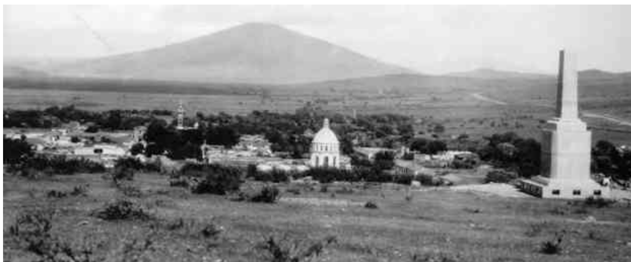
Fig. 03. Fotografía histórica panorámica del sitio de emplazamiento en la década de los 30 del siglo XX, con vista al oriente de la ciudad de Jiquilpan, tomada desde la loma de Aguatepec. Al frente se ubica el monumento de la Trasquila construido en 1934. Fuente: Acervo Fotográfico histórico, Unidad Académica de Estudios Regionales, UNAM, Jiquilpan
