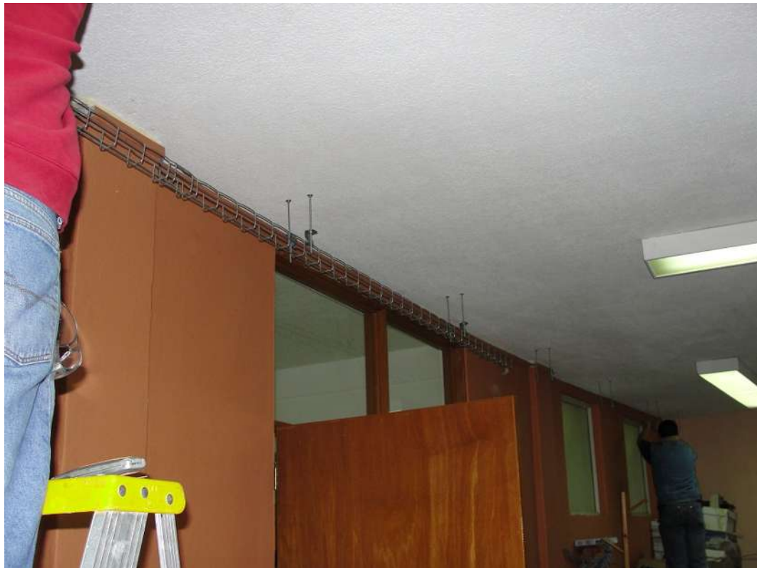
Figura 4.8. Instalación de escalera.
