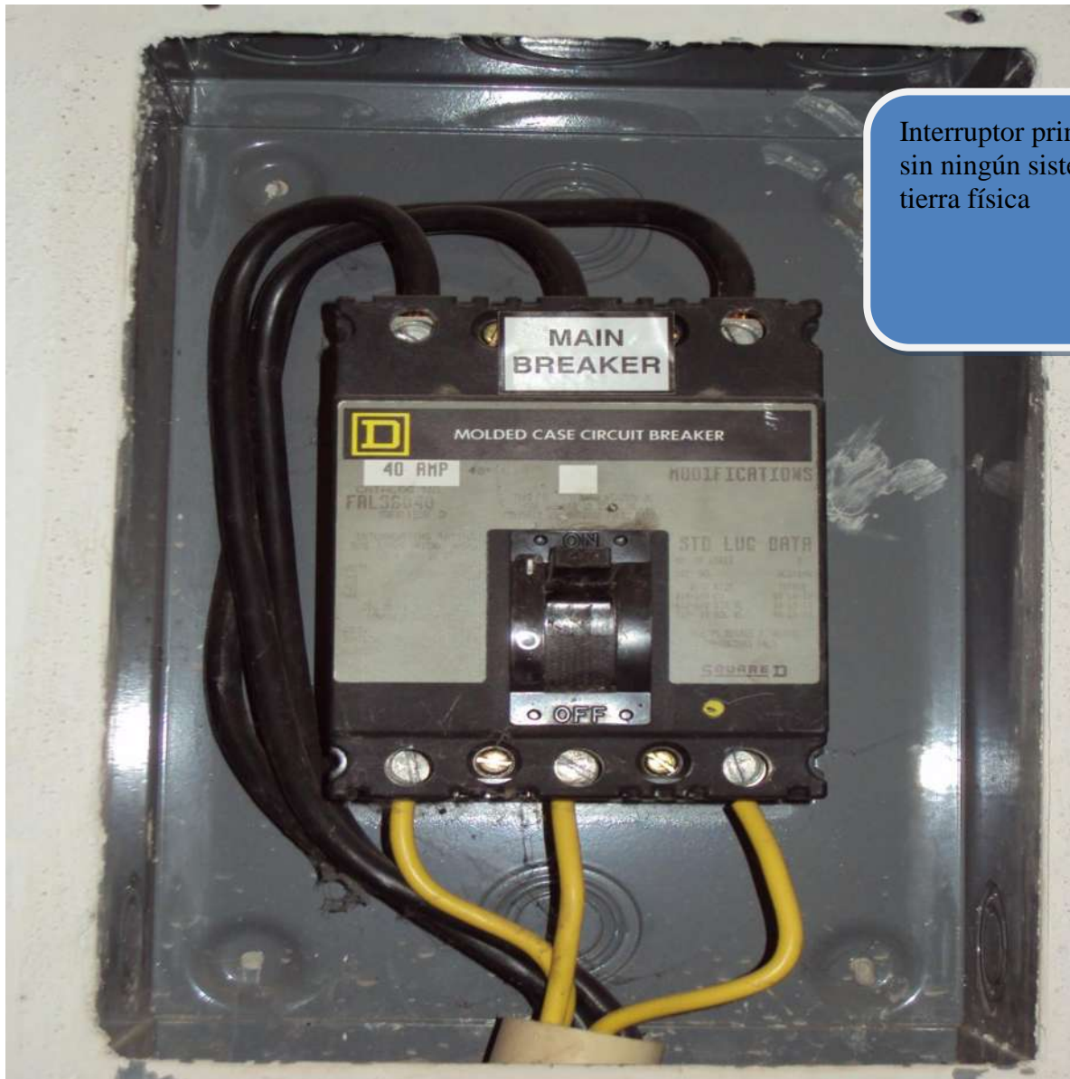
Fig. 3.2.3 Interruptor termo magnético
