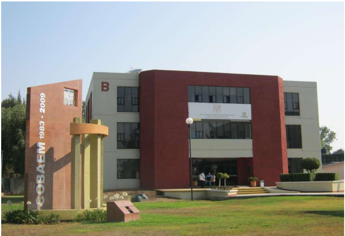
Fig. 2.1.2. Edificio “B” de la Dirección General del Colegio de Bachilleres
