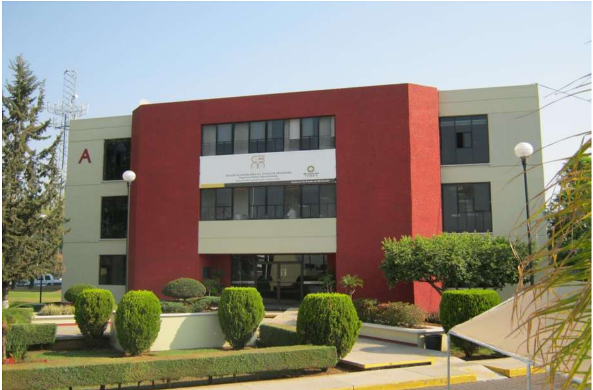
Fig. 2.1.1. Edificio “A” de la Dirección General del Colegio de Bachilleres
