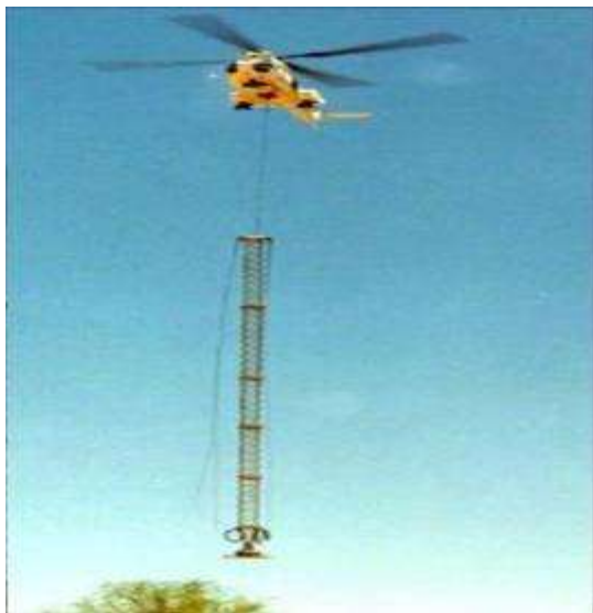
Figura 2.18 Traslado de estructura de un sitio diferente a su instalación.
