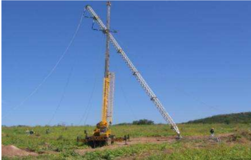
Figura 2.15 Estructura pivoteada a \frac{2}{3} de su base con grúa.
