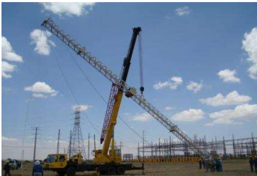
Figura 2.16 Izaje de estructura utilizando el método de centro de gravedad.
