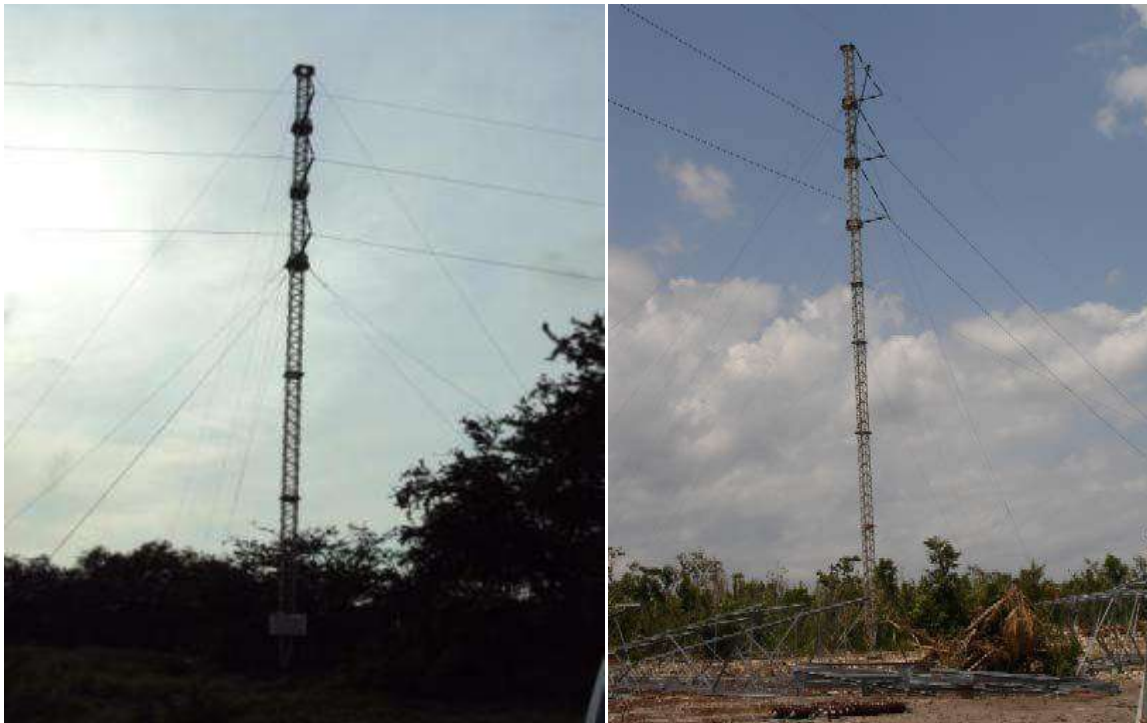
Figura 2.12 Estructuras tipo Bandera.
