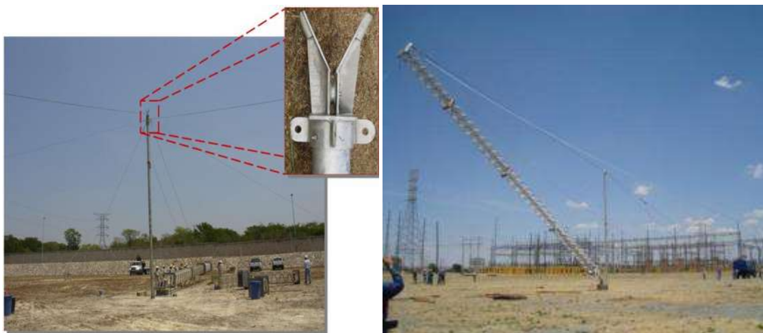
Figura 2.19 Estructura pivoteada sobre su base y levantada con apoyo de una pluma fija.
