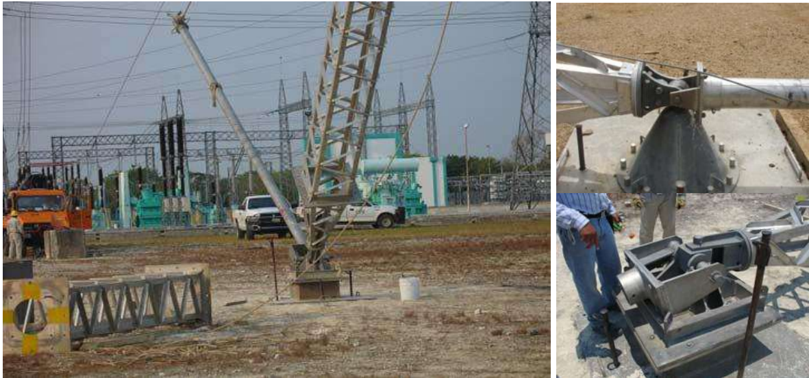
Figura 2.20 Estructura pivoteada sobre su base y levantada con apoyo de una pluma móvil.
