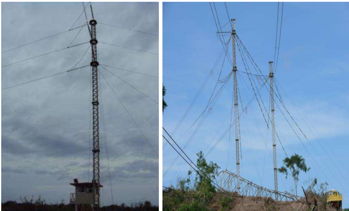
Figura 2.13 Estructuras tipo Tensión.
