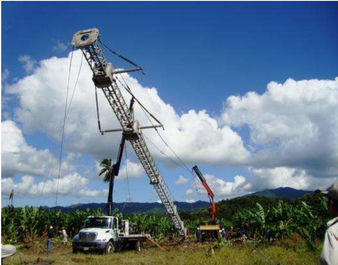
Figura 4.6 Izaje con grúa de la estructura tipo Delta.
