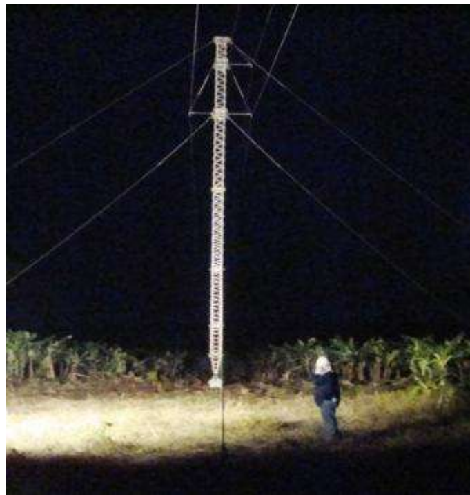
Figura 2.11 Estructura tipo Delta.
