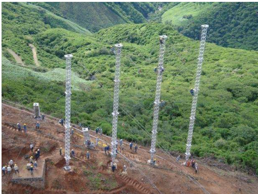
Figura 2.14 Estructura tipo 4 Columnas.
