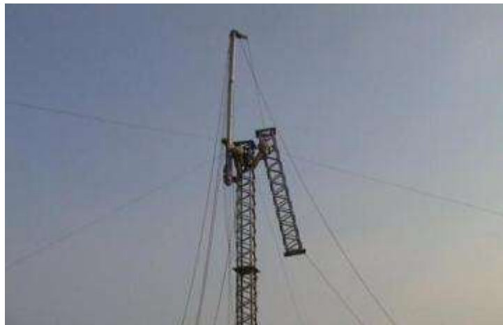
Figura 2.21 Estructura armada módulo por módulo con apoyo de una pluma flotante o deslizante.
