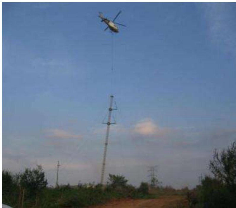
Figura 2.17 Izaje de estructura mediante el uso de helicóptero.
