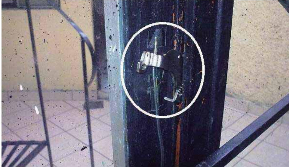
Fig. 5.4 Unión del imán y el sensor magnético.
