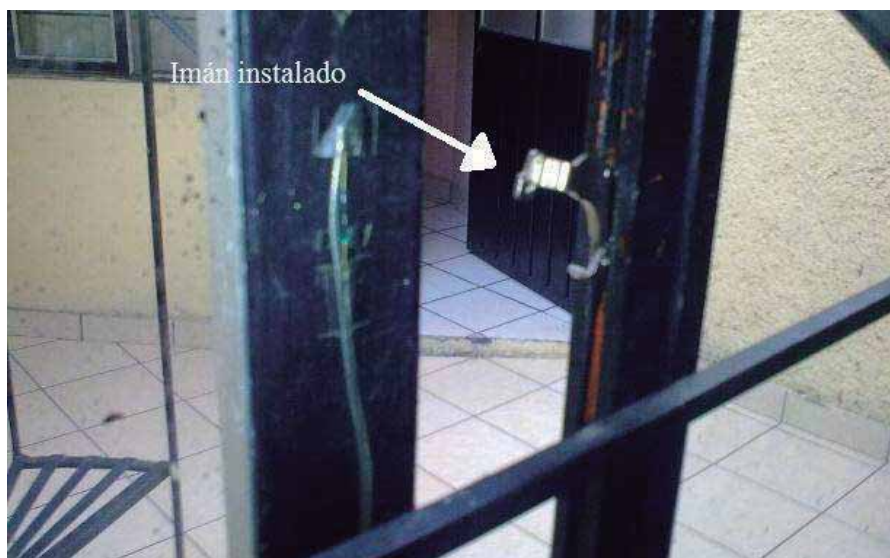
Fig. 5.3 Instalación del imán en la ventana.
