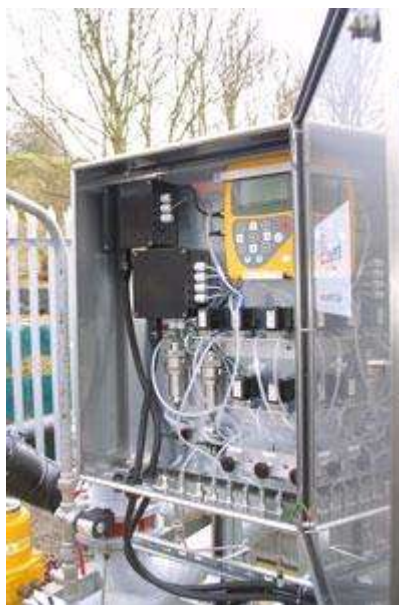
Figura 4-8 Analizador de biogás.
