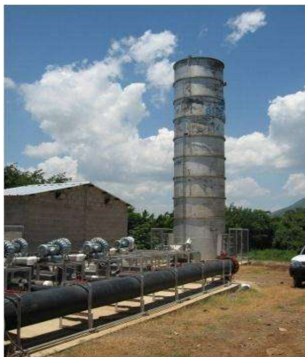
Figura 4-10 Quemador tipo cerrado.
