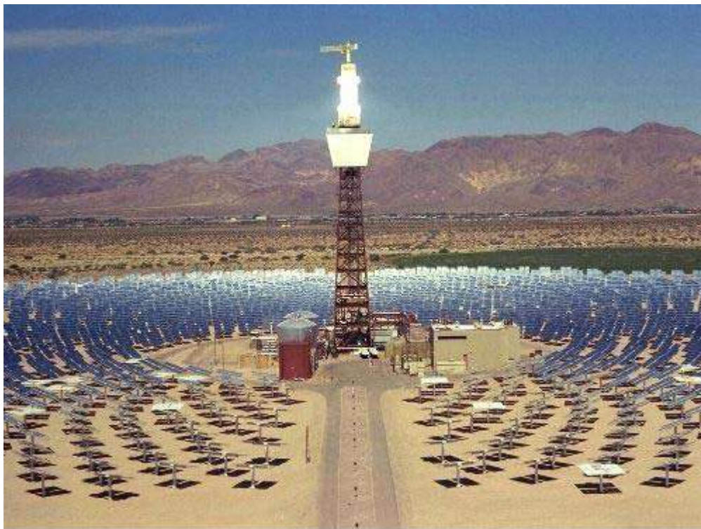
Figura 4.3: Planta Solar II
