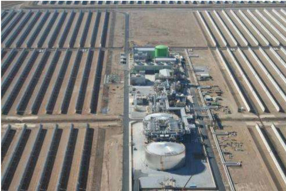
Figura 4.5: Planta de Generación Andasol 1
