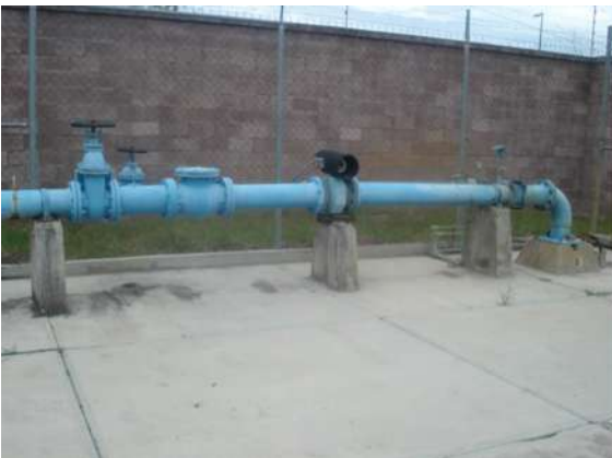
Figura 4.12. Entubamiento del pozo
