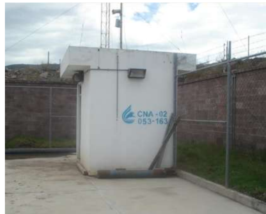
Figura 4.4 Cuarto de control
