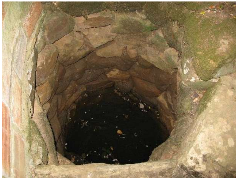
Figura 4.1 Pozo excavado
