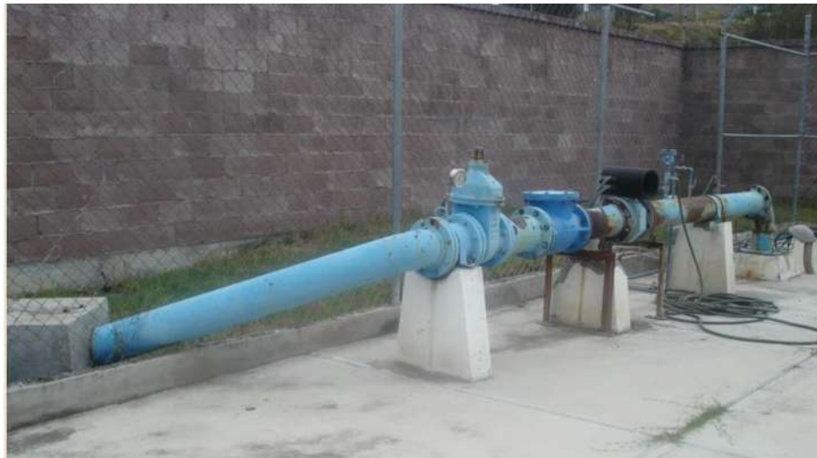
Figura 4.7. Entubamiento del pozo
