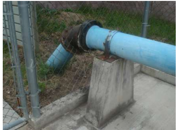
Figura 4.13. Salida del pozo
