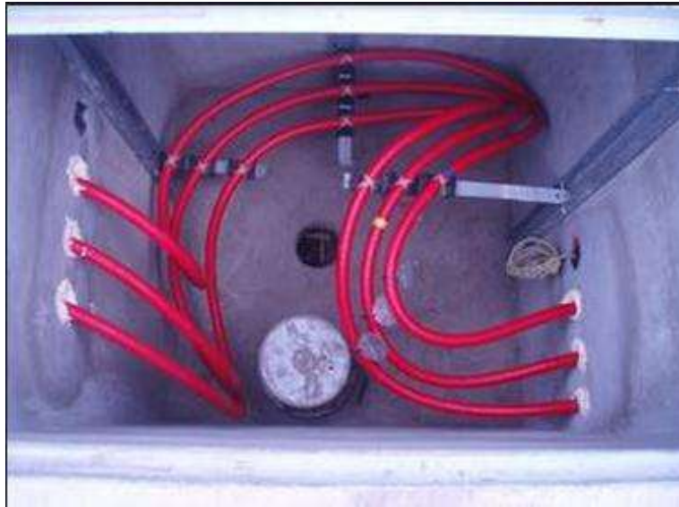
Figura 4.31 Registro eléctrico REH-6-7
