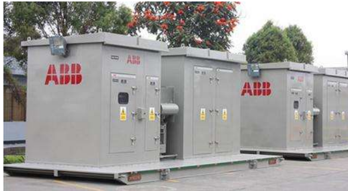
Figura 4.5 Subestaciones unitarias (compactas) tipo intemperie
