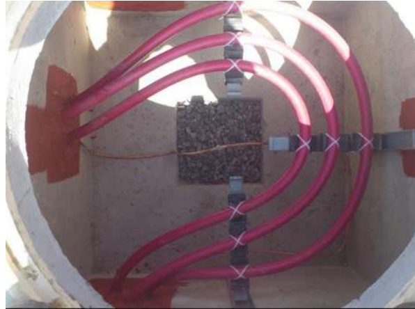
Figura 4.18 Registro eléctrico
