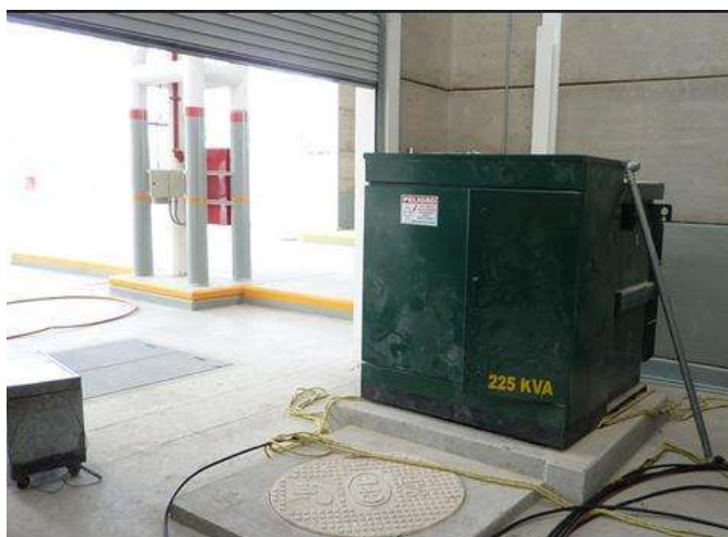
Figura 4.8 Subestación tipo blindado
