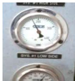
FIGURA 11 Monitores De La Presión Del Sistema Sellado
