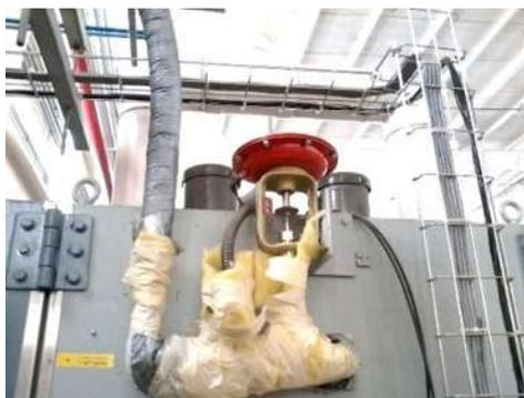
FIGURA 15 Válvula De Nitrógeno
