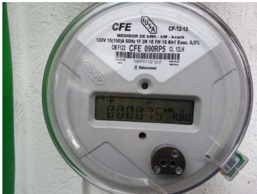
Figura 2. 23 Wathhorímetro digital bidireccional empleado por CFE.
