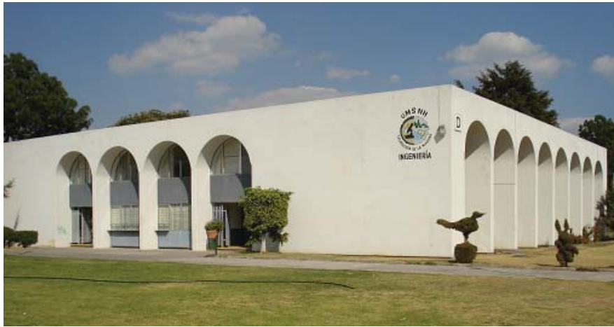
Figura 15. Vista exterior en dirección noreste del edificio “D”.
