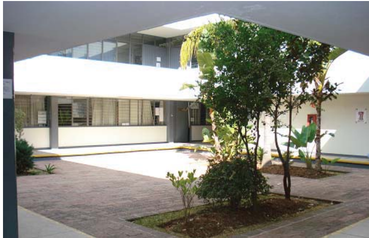
Figura 17. Vista interior en dirección NE del edificio "D".
