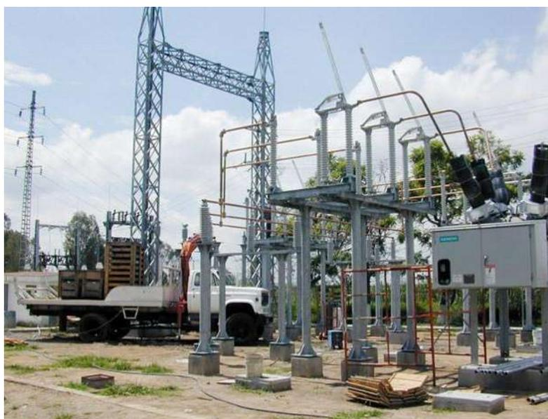
**Figura 6.- Montaje de Cuchillas Seccionadoras**
