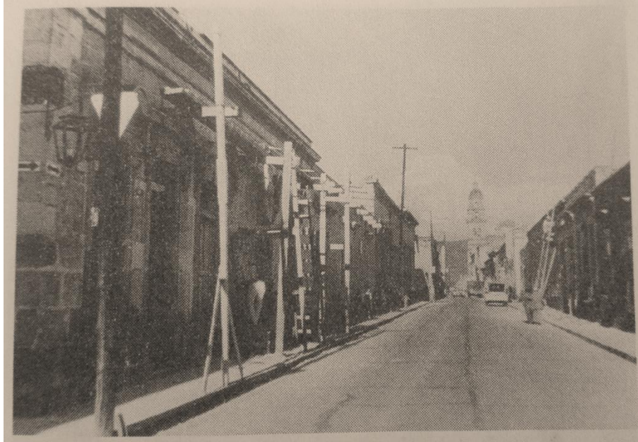
Fig. 04. Liberación de aplanados en fachadas de calle Corregidora de poniente a oriente. Fuente: Manuel González Galván, "Morelia: Autenticidades y Ocultamientos" en Louise Noelle (ed.), La Ciudad: Problema integral de preservación patrimonial , México, Universidad Nacional Autónoma de México, Instituto de Investigaciones Estéticas, 2004, p. 95.
