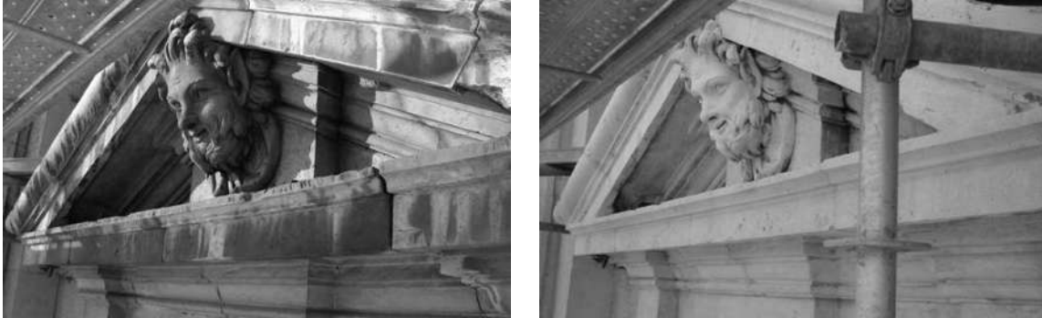
Fig. 09. Alteración de la superficie pétreo por contaminación antrópica. Imagen izquierda con deterioro, imagen a la derecha después del proceso de restauración. Fuente: Enrique Salgado, Restauración del Palacio Real de Madrid, [28 de marzo de 2017], http://www.esalgado.es/restauracion-del-palacio-real-de-madrid .
