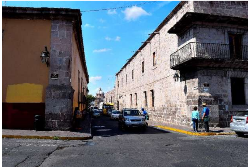
Fig. 40. Fachada de inmueble orientado al sur, calle Santiago Tapia, Morelia Michoacán. Fuente Aldo Zamudio Pérez, 2017.
