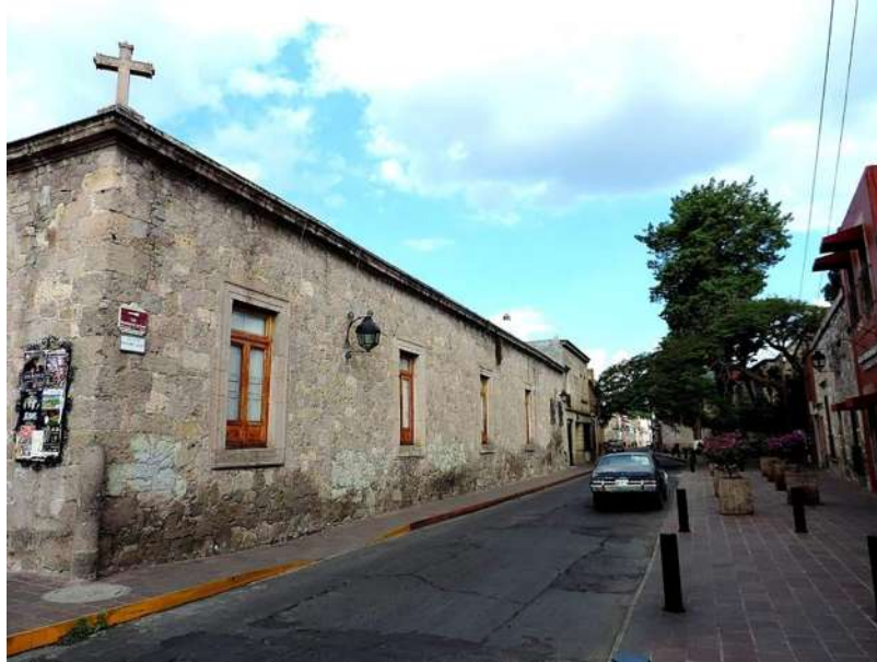
Fig. 33. Humedad por capilaridad en mamposterías de calle Bartolomé de las Casas en Morelia Michoacán. Fuente Aldo Zamudio Pérez, 2017.
