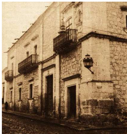
Fig. 26. Fotografía de inmueble ubicado en la actual calle Morelos Sur #323, Colonia Centro de Morelia, sin recubrimientos en sus muros de fachada. Fuente: [enero 2017] http://www.mexicoenfotos.com/antiguas/michoacan/morelia/casa-de-morelos-MX14172106956024/12
