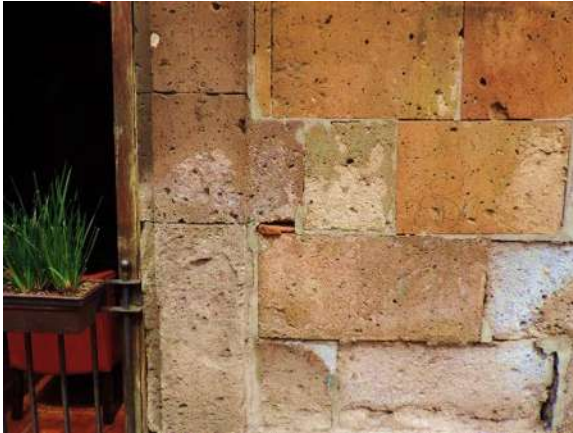
Fig. 20. Disyunción de películas, disgregación y descamación en la ignimbrita de inmueble ubicado en calle Galeana, Morelia, Michoacán, México. Fuente: Aldo Zamudio Pérez, 2017.
