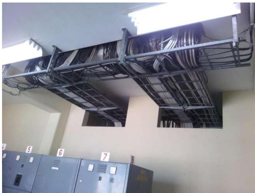
Figura 2. 17 Bandejas que suben al piso de control.
