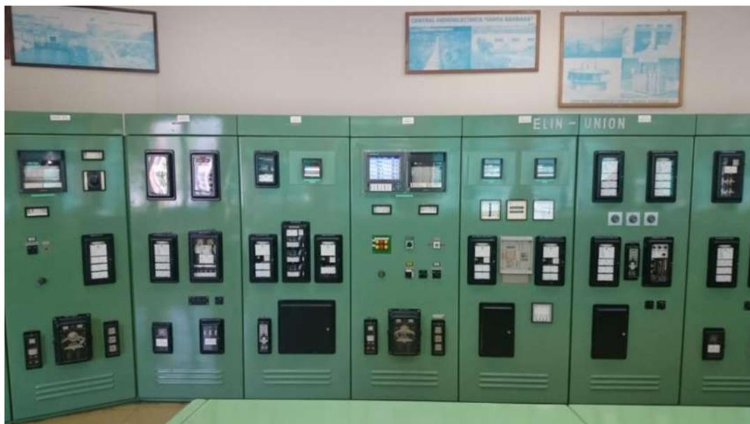
Figura 2. 14 Tableros de protecciones.
