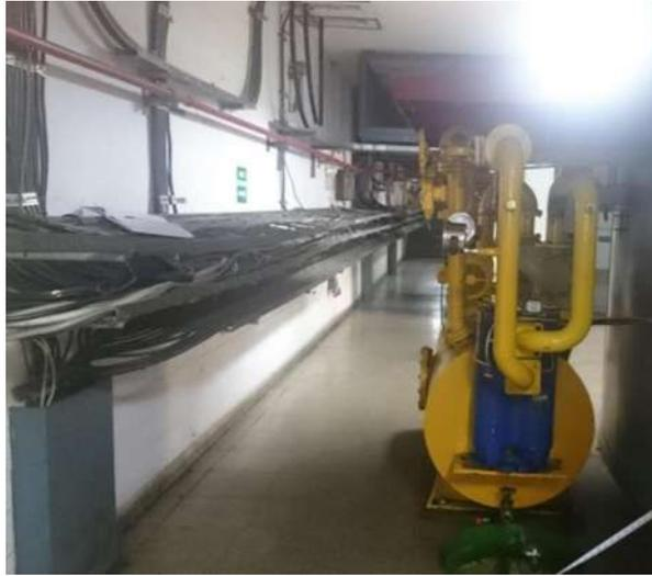
Figura 2. 6 Unidad hidráulica generador 2 PCF.
