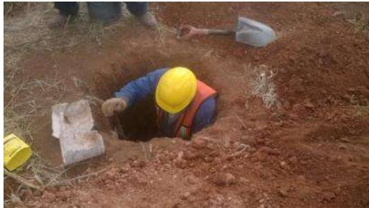
*FIGURA 12.- EXCAVACIÓN MANUAL PARA POSTE DE SECCIÓN I*
