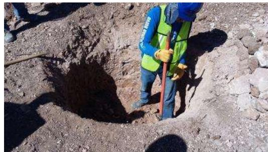
*FIGURA 10.- EXCAVACIÓN MANUAL PARA POSTE TRONCOCÓNICO*
