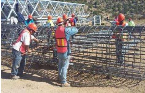
FIGURA 16.- ARMADO DE VARILLA PARA UN POSTE TRONCOCÓNICO
