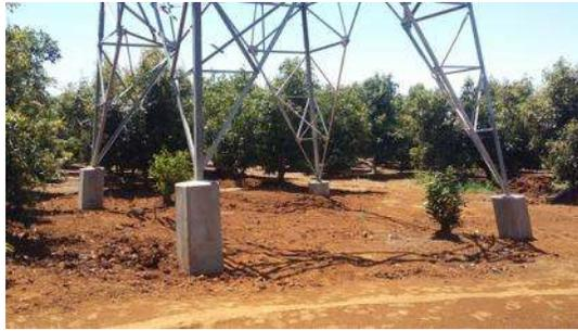
*FIGURA 23.- CIMENTACIÓN DE TORRE TERMINADA*
