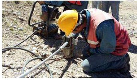
FIGURA 41.- COMPRESIÓN DE GRAPA DE TENSION
