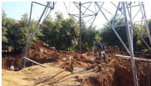
FIGURA 22.- NIVELACIÓN DEL BOTTOM-PANEL
