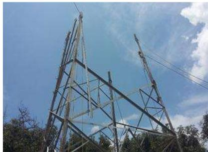
*FIGURA 25.- TORRE MONTADA CON PLUMA FLOTANTE*
