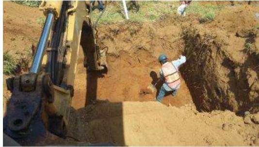
*FIGURA 9.- EXCAVACIÓN PARA LA CIMENTACIÓN DE UNA TORRE DE REMATE*
