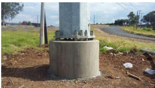
*FIGURA 19.- CIMENTACIÓN DE POSTE TRONCOCÓNICO TERMINADA*
