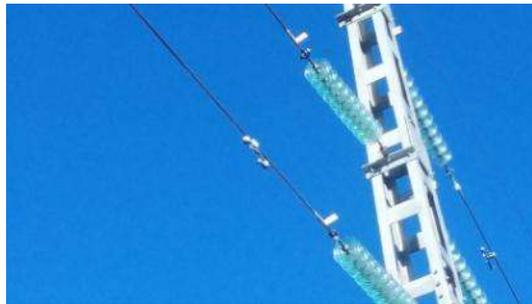
FIGURA 43.- AMORTIGUADOR EN CABLE
