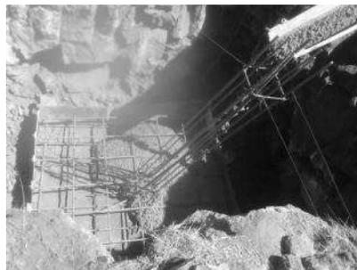
FIGURA 14.- ARMADO DE VARILLA PARA LA CIMENTACIÓN DE UNA TORRE DE ACERO
