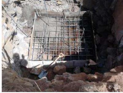
*FIGURA 18.- ARMADO DE VARILLA PARA LA CIMENTACIÓN DE UN POSTE TIPO MORELOS*
