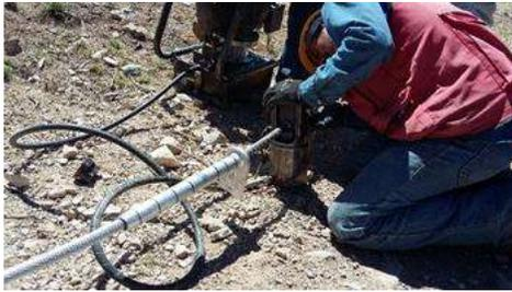
FIGURA 40.- EMPALMADORA PARA COMPRIMIR GRAPA DE TENSION
