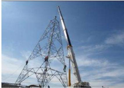
*FIGURA 24.- MONTAJE DE TORRE CON GRÚA HIDRÁULICO*
