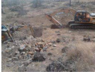
*FIGURA 11.- EXCAVACIÓN CON MAQUINARIA PARA POSTES TIPO MORELOS*
