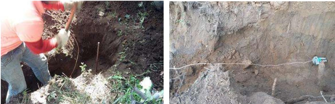
FIGURA 29.- CONEXIÓN DE CABLE A VARILLA
