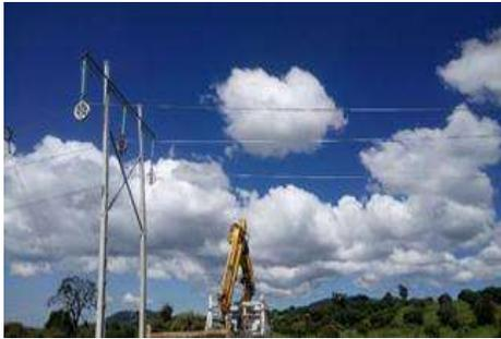
**FIGURA 36.- TENDIDO DE CABLE CONDUCTOR**
