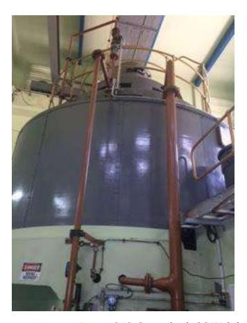
Imagen 3.13. Generador de 6.9 KV de la planta Maggotty A
