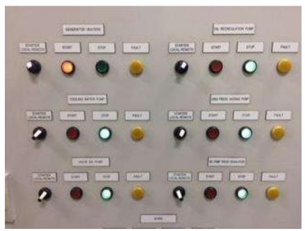
Imagen 3.14 Parte de la puerta del tablero de Auxiliares armado en el taller de Andritz Morelia, del proyecto Maggotty A
