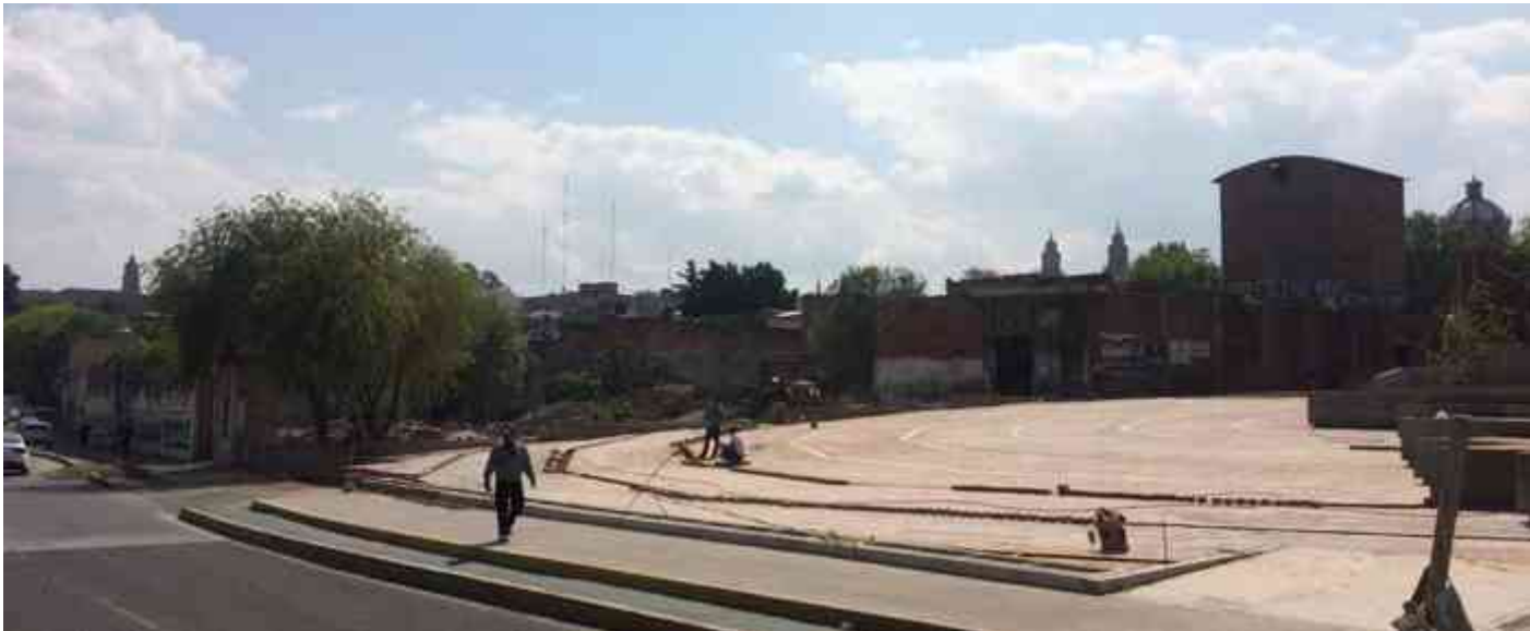
Figura 49. Foto del área donde se construye la Plaza de la Paz. Antigua infraestructura industrial.
