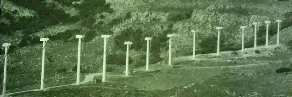
Figura 2.22. Maquinas alineadas transversalmente a la corriente de aire
