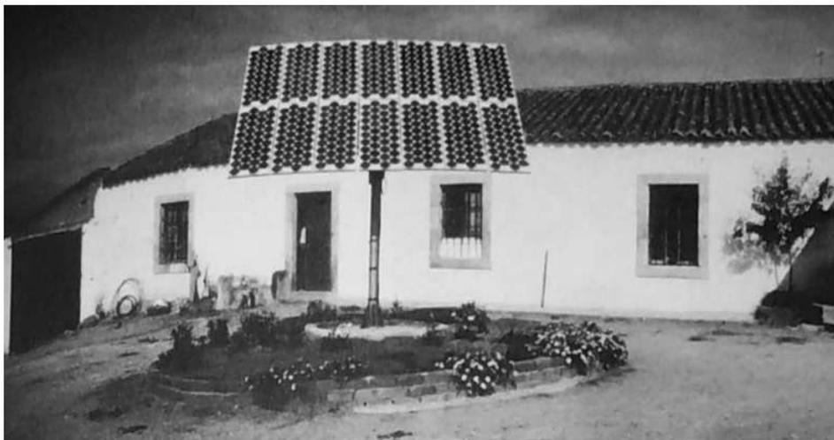
Figura 3.13. Vivienda electrificada con un generador fotovoltaico
