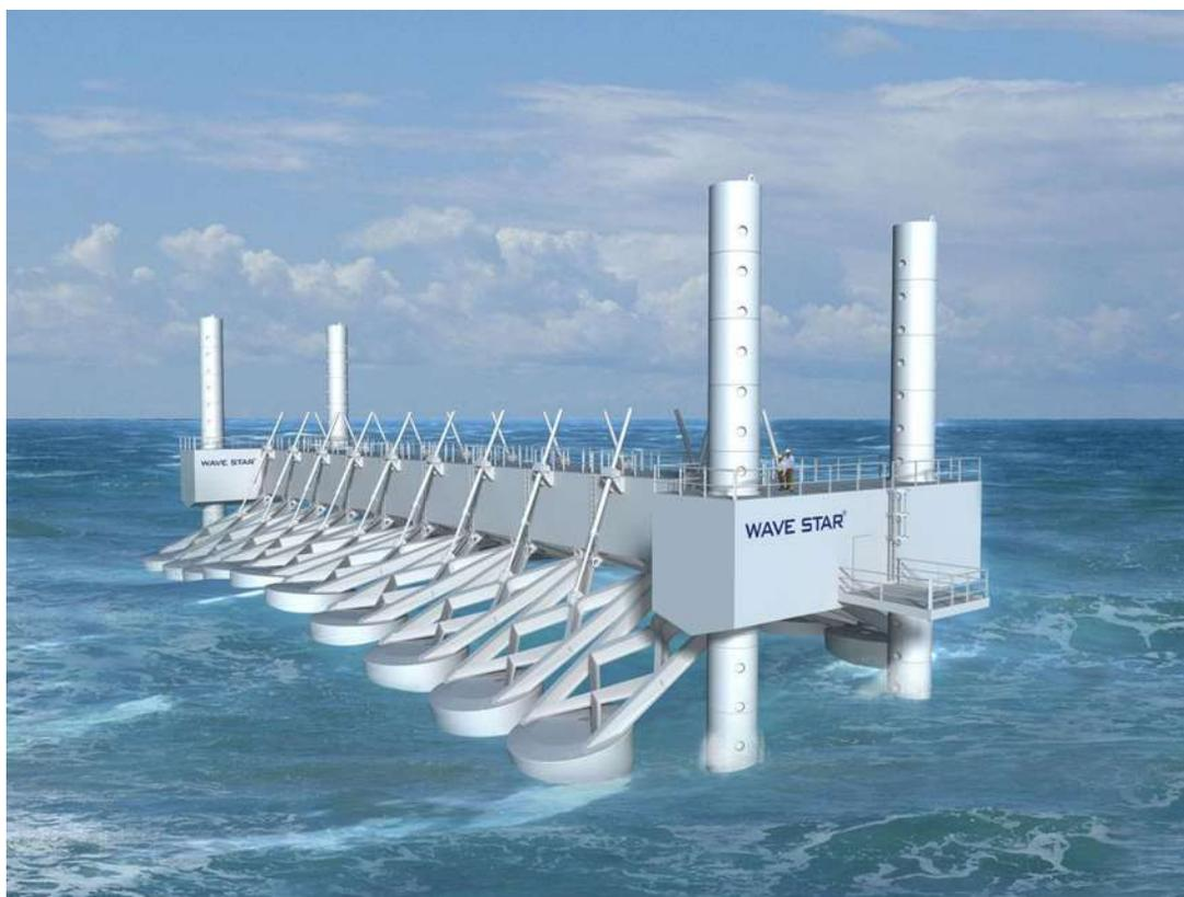
Figura 1.5. Diseño de una central Undimotriz
