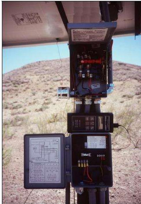
Figura 3.3. Controlador típico de un sistema fotovoltaico de bombeo
