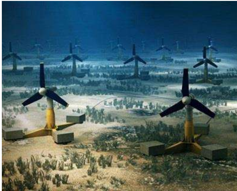
Figura 2. 27.- Esquema de una turbina de flujo cinético de las corrientes marinas.
