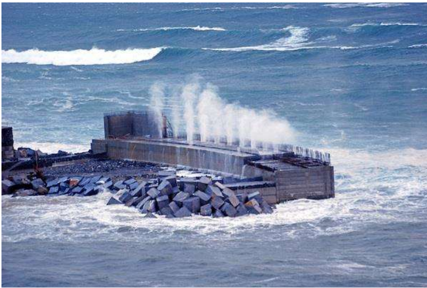
Figura 3. 14.- Central eléctrica convertidor Columna de Agua Oscilante Mutriku.
