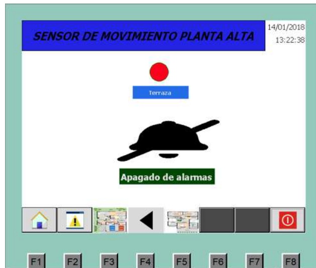
Figura 5.27: Alarma activa sensor de movimiento planta alta.
