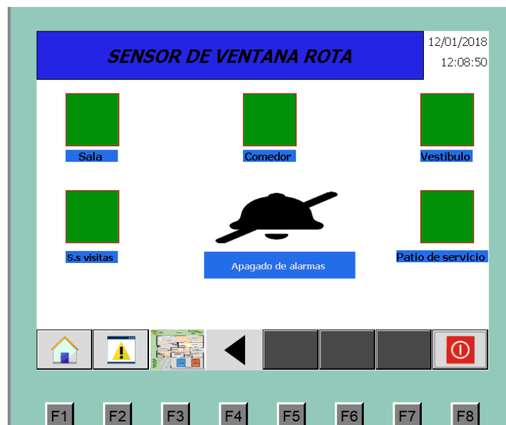
Figura 5.20: Alarma desactivada sensor ventana rota.
