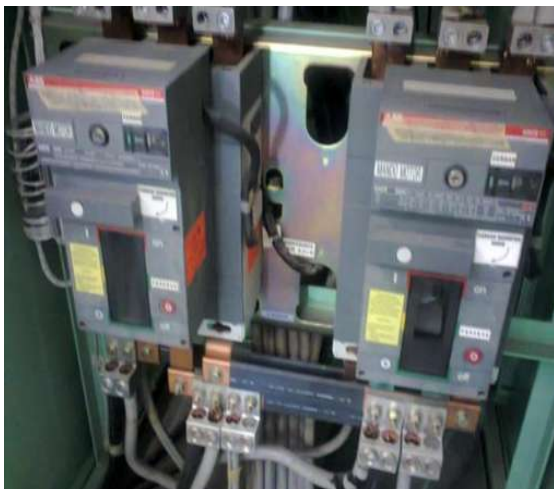
Figura 16.- Transfer con Motor Universal
