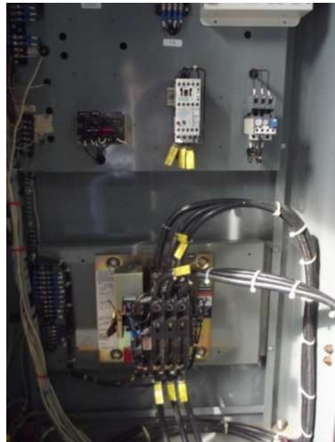
Figura 17.- Transfer de 2 Tiros y una sola Bobina
