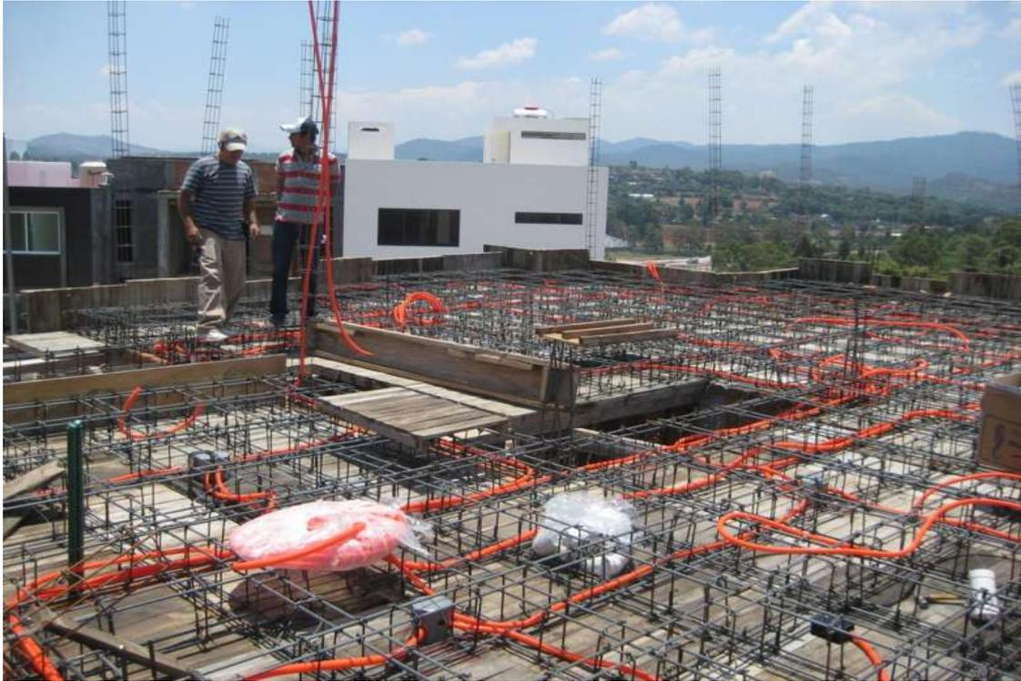
*Figura 3.3 Prueba de tubería naranja y accesorios losa aligerada.*
