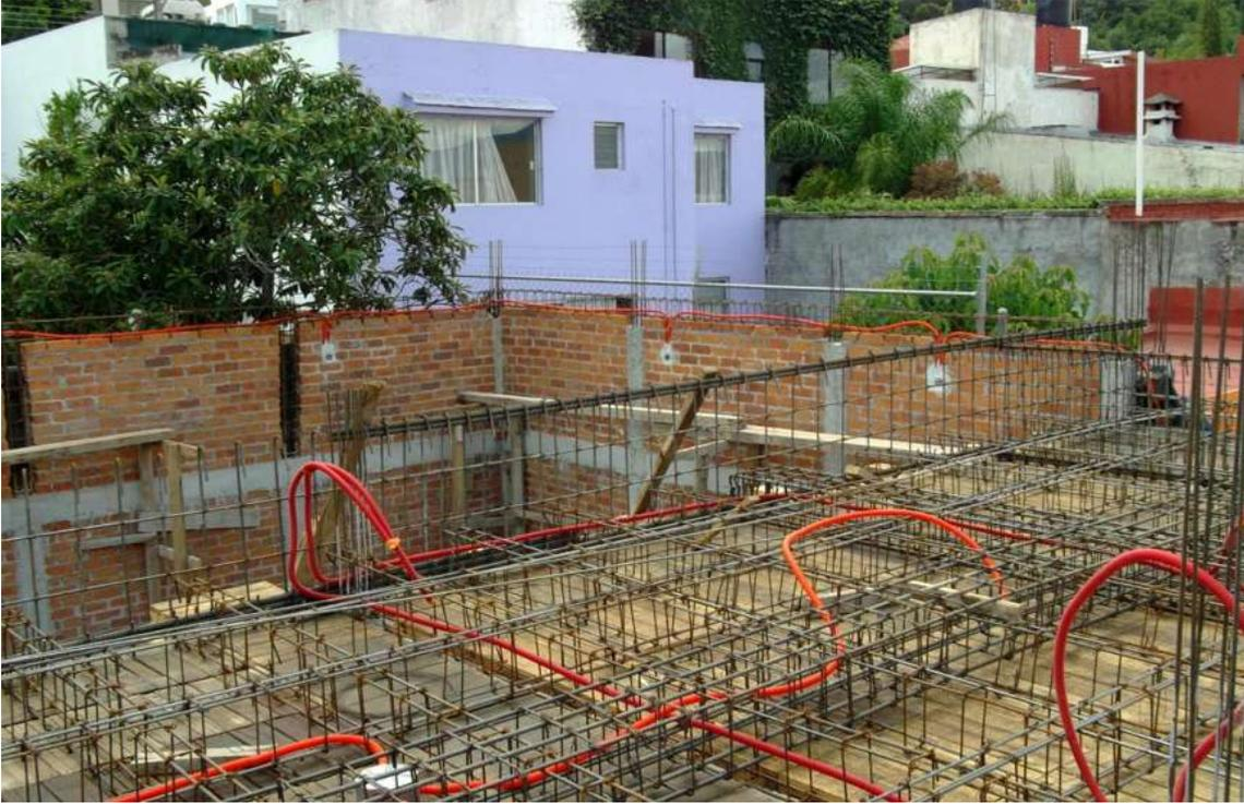
*Figura 3.5 Prueba de dos tipos de tuberías en losa aligerada*
