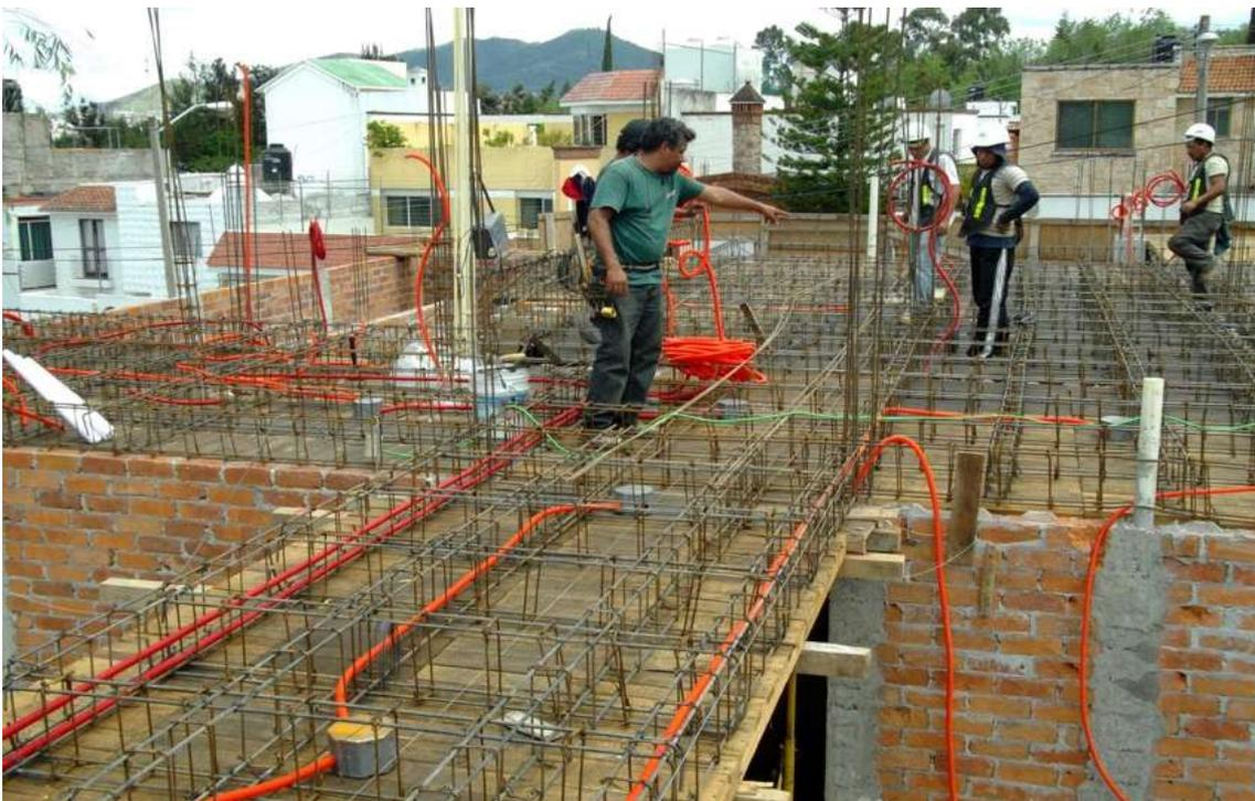
*Figura 3.4 Prueba con dos colores de tubería para identificación en losa aligerada y vigas de carga.*
