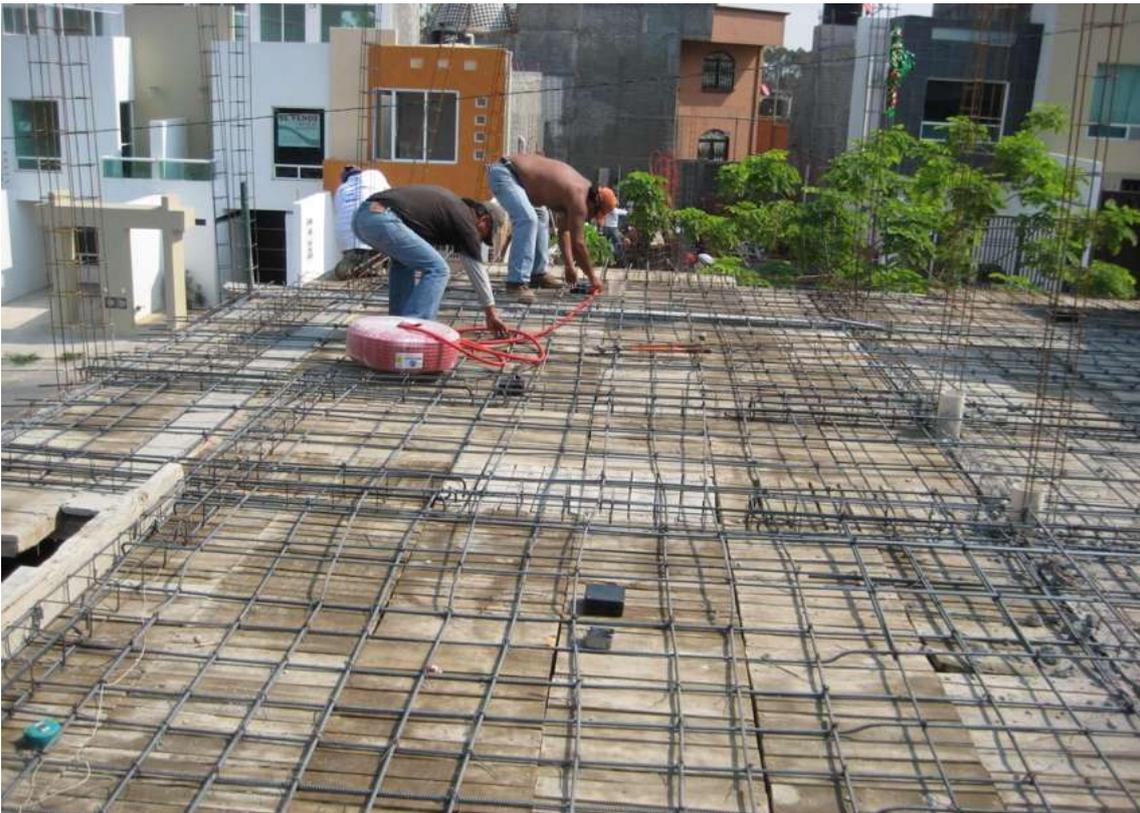
*Figura 3.6 Prueba con tubería extra resistente y accesorios en losa sólida.*
