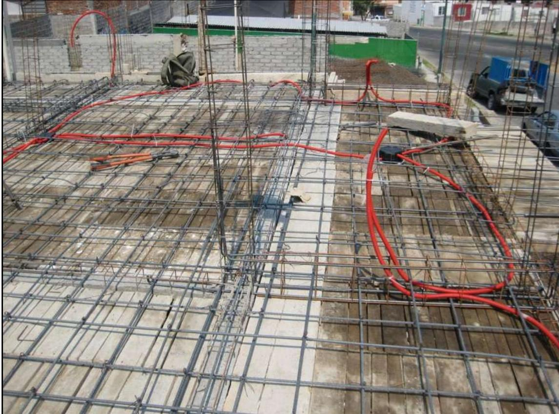
*Figura 3.7 Prueba con tubería extra resistente y accesorios en losa sólida.*
