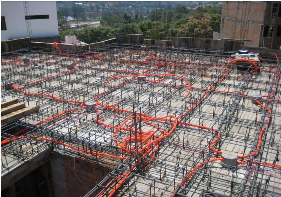
*Figura 3.2. Prueba en tendido de tubería con losa aligerada.*
