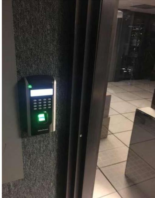
**Figura 3.6** Sistema Biométrico del SITE de la SFA.
