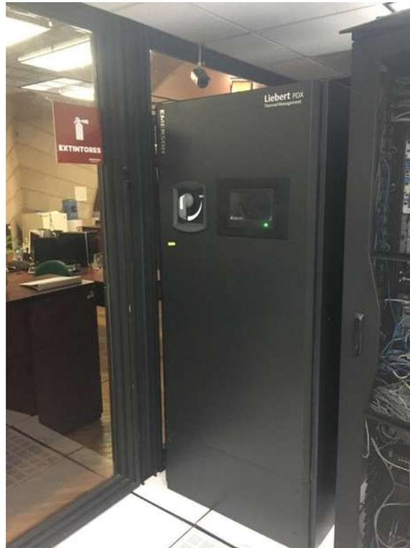
**Figura 3.5** Sistema de Aire Acondicionado del SITE de la SFA.
