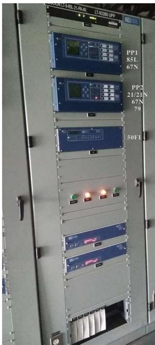
Figura 23.- Tablero de Protección de la L.T. CRP-93390-UPP, en el extremo de CRP.
