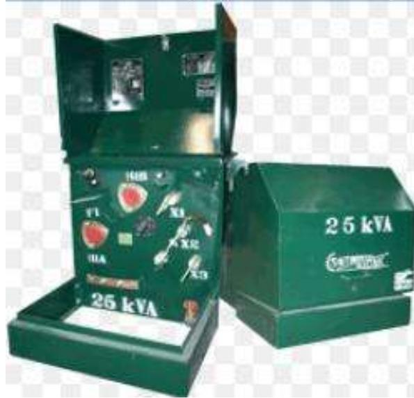
Figura 6.-Imagen de un transformador tipo pedestal para el sistema de alumbrado público de Lomalta Tres Marías, Morelia Michoacán
