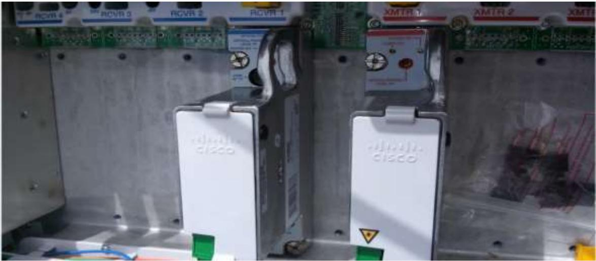
*Fig 4.15 Receptores de la señal de fibra óptica*
