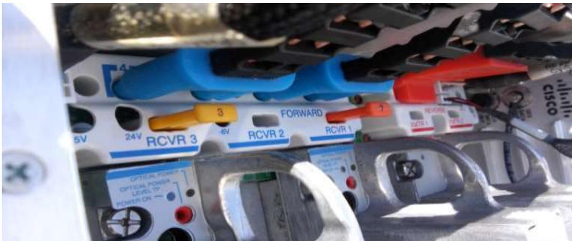
*Fig 4.14 Instalación de las conexiones con los mini coaxiales*
