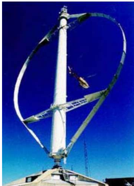
Figura 1.4 Aerogenerador Darrieus
