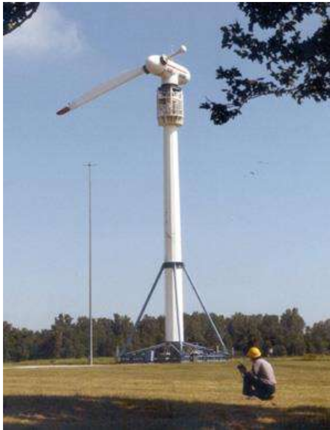
Figura 1.6 Aerogenerador Monopala de la NASA.
