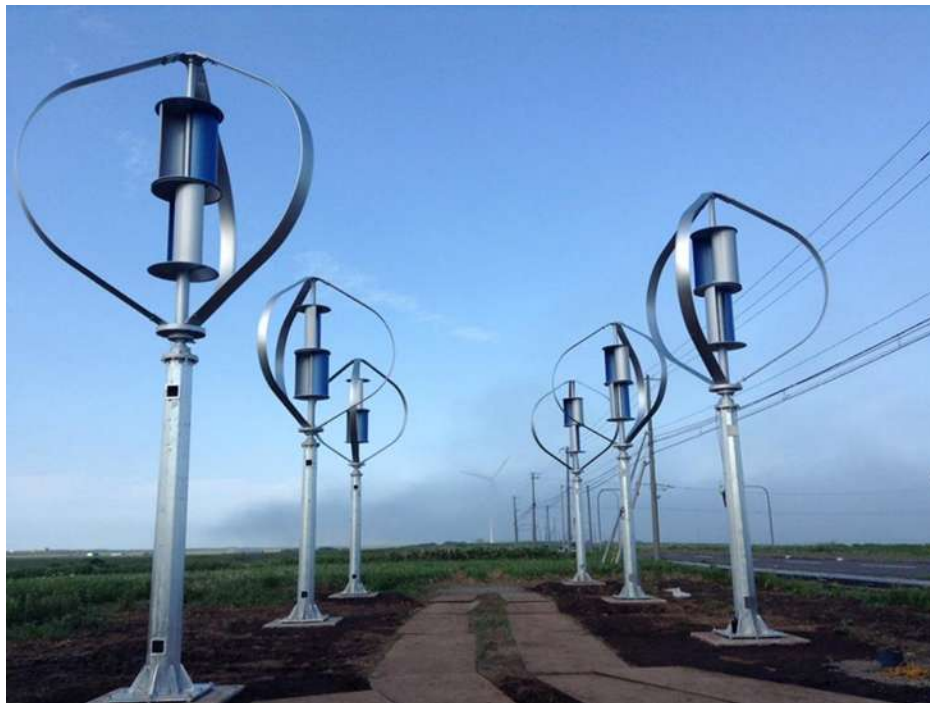
Figura 1.5 Mini parque eólico en Japón por la empresa Etno, instalación de 6 turbinas de 3 KW cada una.
