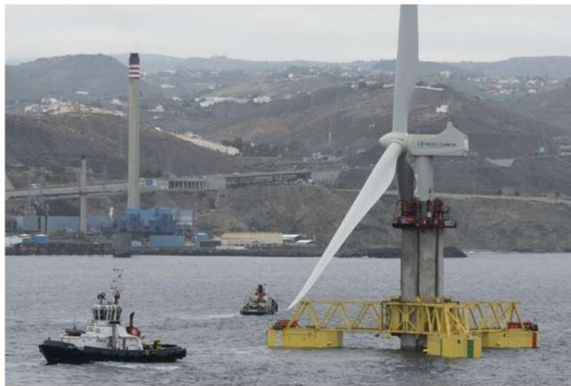
Figura 1.10 Torre eólica tipo offshore de tres palas en España.
