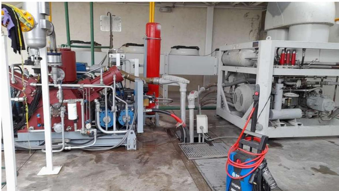
Figura A10 Compresor FORNOVO a la izquierda y Compresor ASPRO a la derecha.
