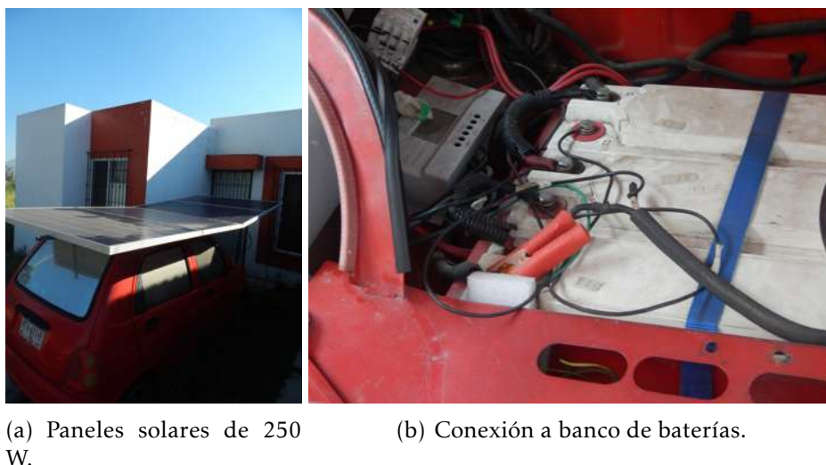
Figura 4.1: Instalación de NDCE.
