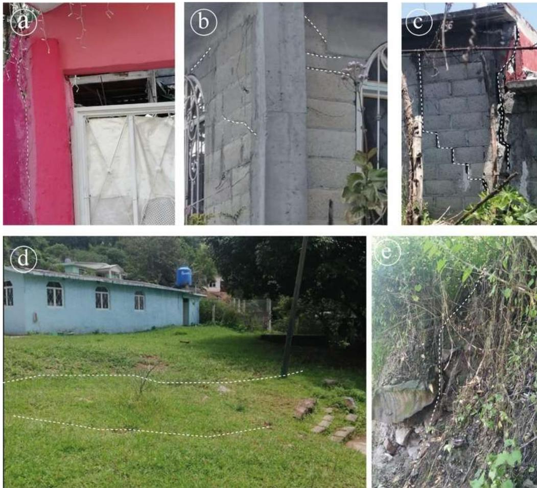
**Figura 53.** *Fracturas que se observan en el cuerpo de Las Pilas. a) y b) Fracturas sobre casas en la parte superior del escarpe principal del PRMs estudiado en este trabajo. c) Fractura sobre casa en el bloque en rotación del PRMs. d) Grietas sobre el terreno perteneciente a la iglesia de la localidad. e) Fractura sobre el escarpe del PRMs.*
