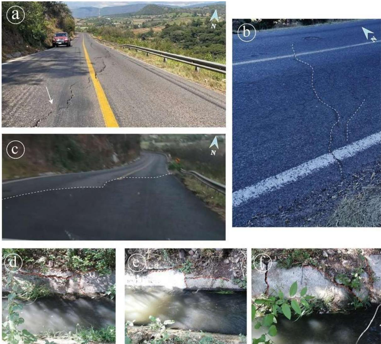
**Figura 31.** a) b) Fracturas sobre la carretera Morelia-Toluca. c) Porción de asfalto de color más oscuro, indicando un ejemplo de los arreglos constantes de la carretera. d), e) y f) Fracturas en el canal inferior.
