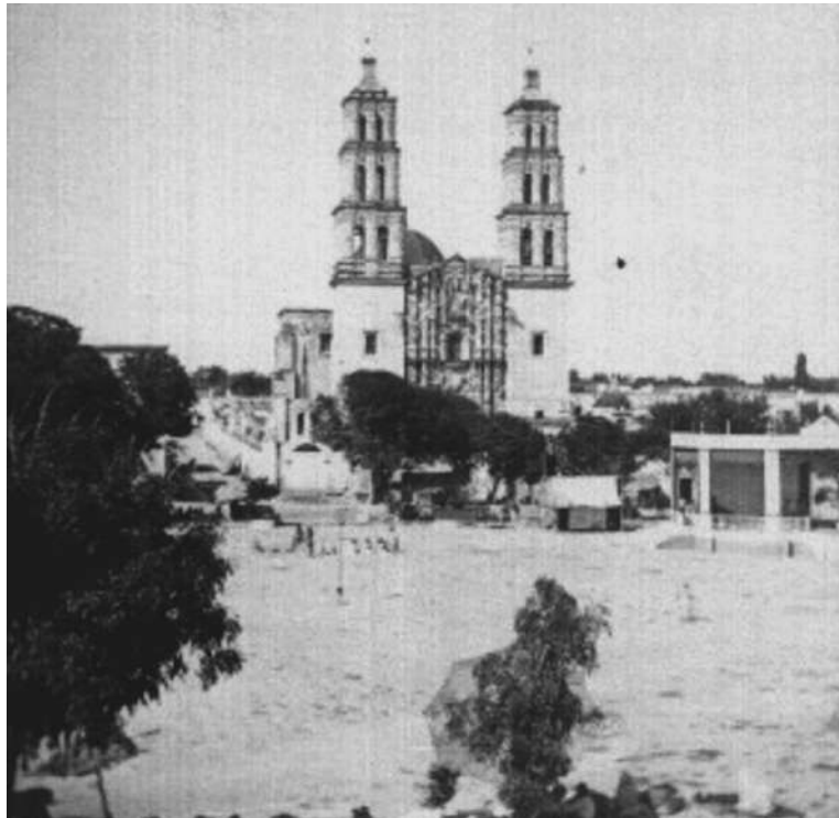
Imagen 6: Se puede apreciar el jacal y el kiosko que dicen contaminaba la vista del monumento a Hidalgo. Ya que no se ven aún iniciados los trabajos del monumento la fotografía es anterior a 1885. 129
