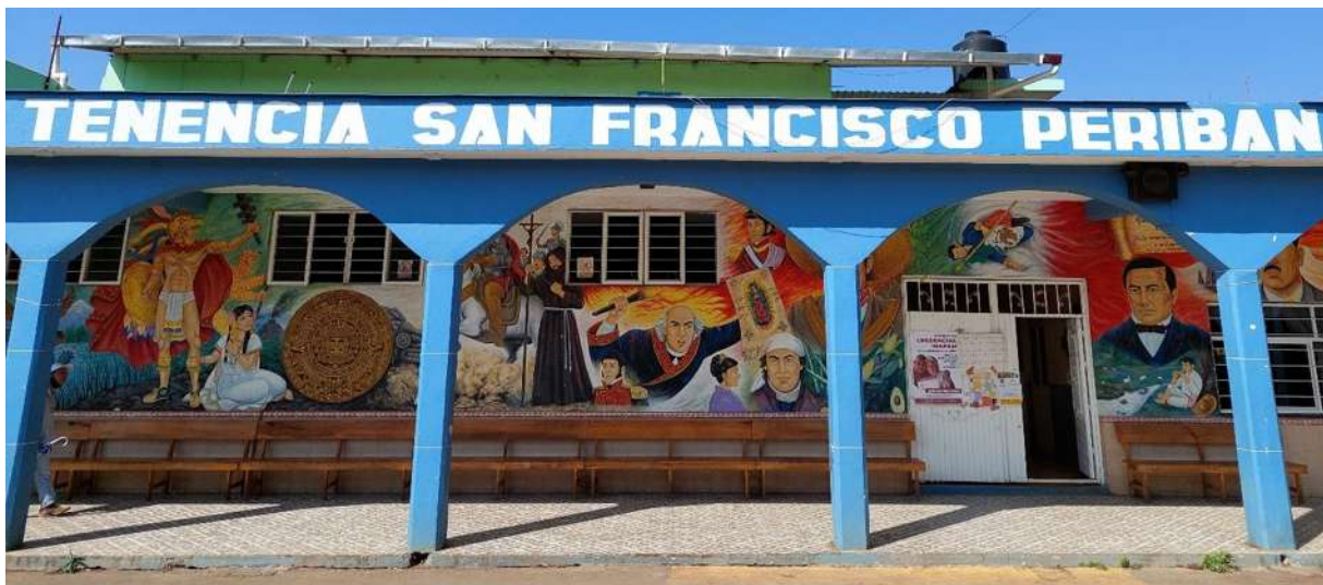
Fotografía 30. Edificio de la jefatura de tenencia de San Francisco Peribán.
