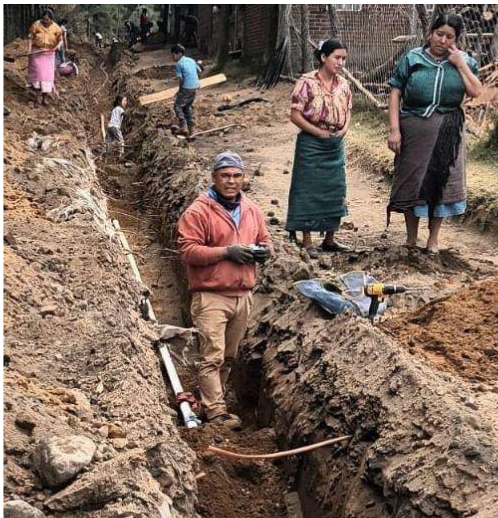
Fotografía 40. Construcción de la red de agua potable en Angahuan.
