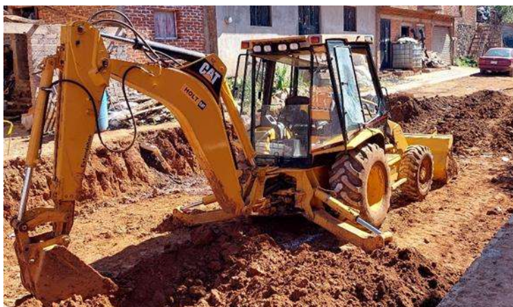
Fotografía 33. Retroexcavadora de La Cantera.
