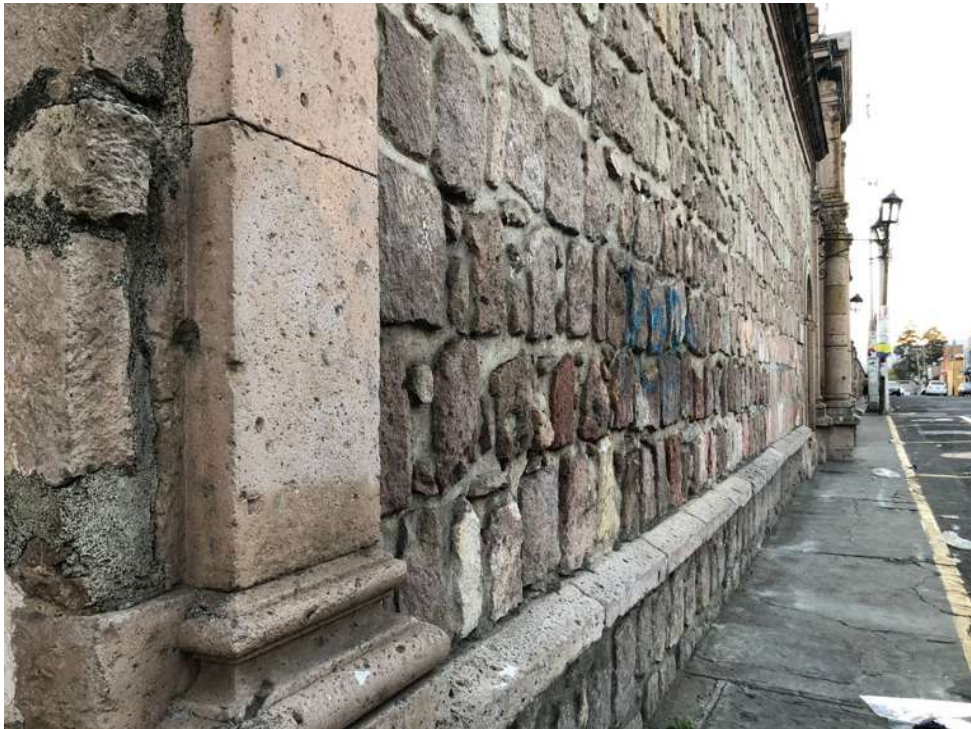
Fig. 71. Muros perimetrales del P.C.M. Fuente: Tomada por Maria Alejandra López Vivanco (2023).
