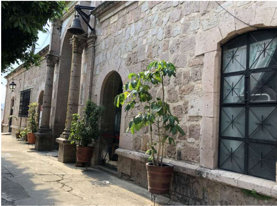
Fig. 72. Muros de la fachada sur del módulo principal. Fuente: Tomada por Maria Alejandra López Vivanco (2023).
