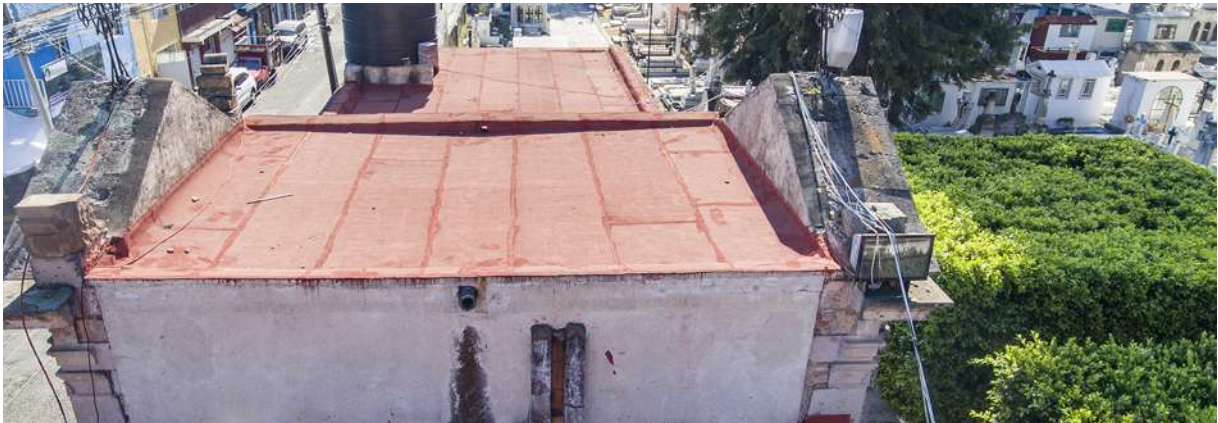
Fig. 77. Vista oeste de la cubierta del módulo principal. Fuente: Tomada por Adrián Solís Sánchez (2023).
