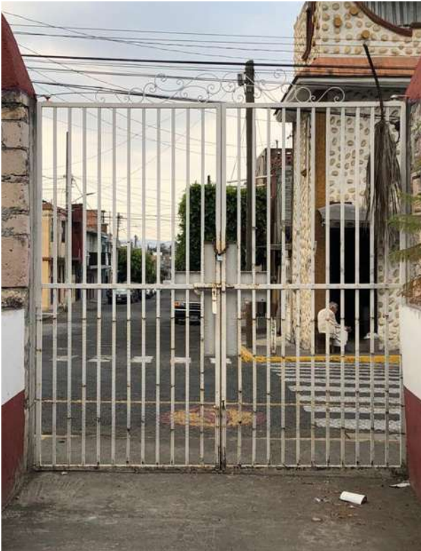
Fig. 81. Puerta ubicada en avenida de La Paz y calle Libertad, herrería tubular contemporánea, se colocó con la finalidad de tener un acceso directo a la capilla. Fuente: Tomada por María Alejandra López Vivanco (2023).
