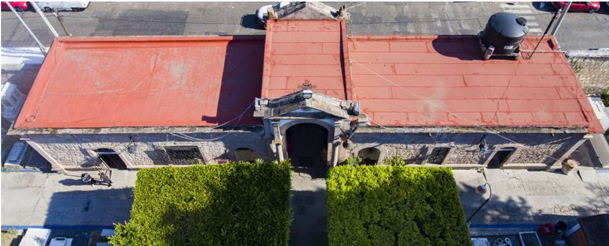
Fig. 73. Vista aérea de la cubierta del módulo principal. Fuente: Tomada por Adrián Solís Sánchez (2023).
