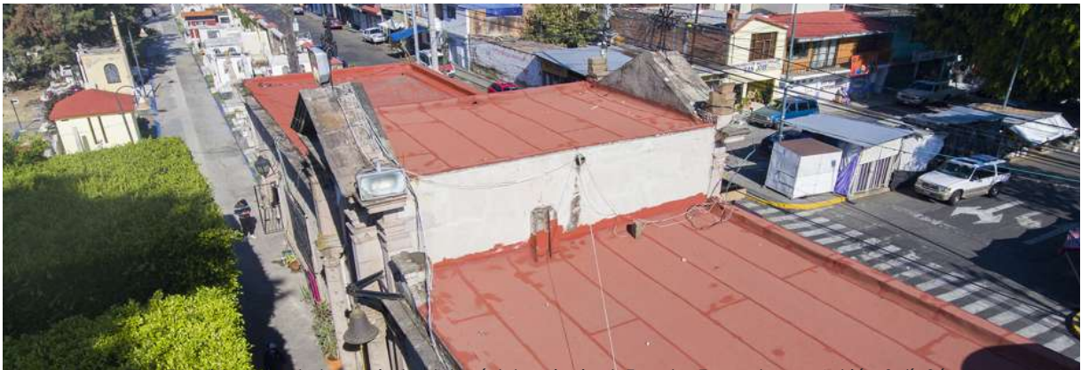
Fig. 76. Vista este de la cubierta del módulo principal. Fuente: Tomada por Adrián Solís Sánchez (2023).
