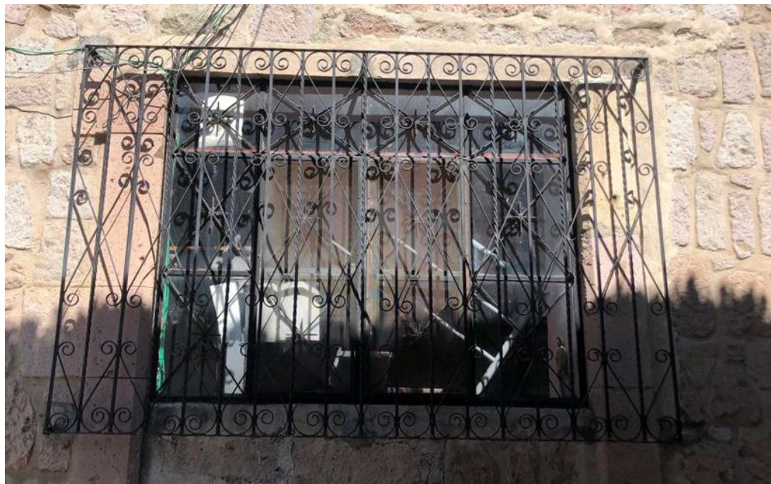
Fig. 85. Protección de herrería forjada, ubicada en el área jurídica, en un inicio esta ventana llegaba al piso. Fuente: Tomada por María Alejandra López Vivanco (2023).
