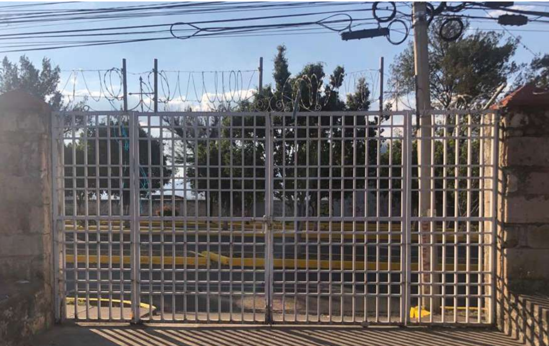
Fig. 83. Puerta ubicada en calzada La Huerta, herrería tubular contemporánea, se colocó con la finalidad de tener un acceso vehicular, con un ancho de cuatro metros. Fuente: Tomada por María Alejandra López Vivanco (2023).
