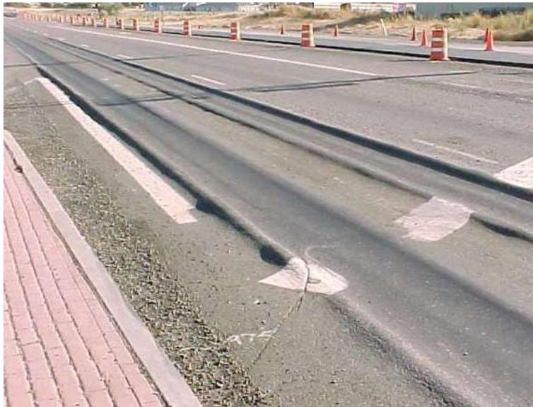
*Figura 38 Falla por deformación permanente de la mezcla asfáltica*
