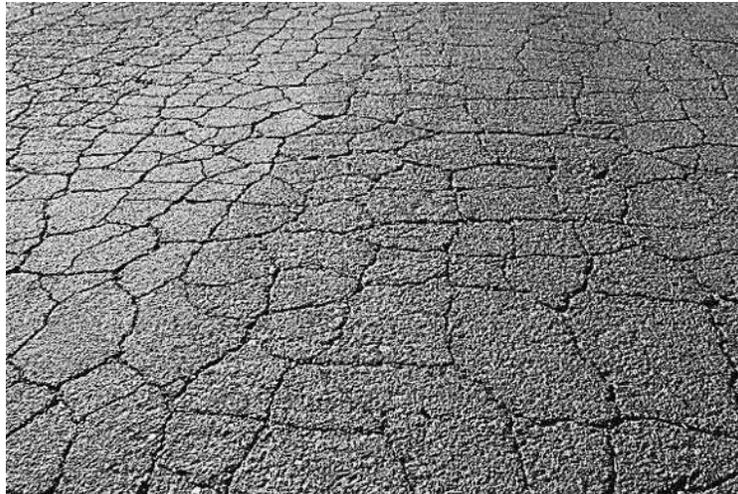
*Figura 37 Falla por fatiga de la mezcla asfáltica*
