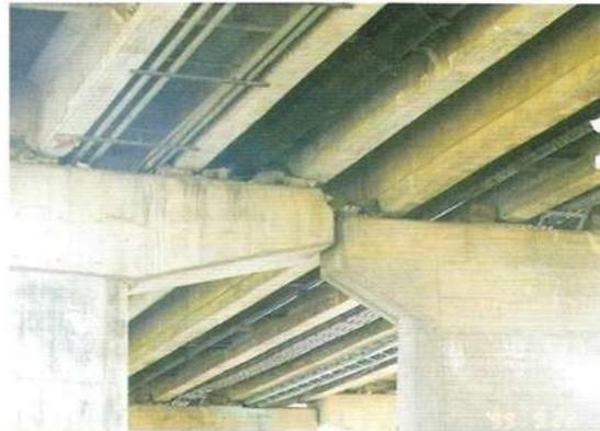
*Figura 1-6. Deslizamiento de la superestructura del puente Don-Fong. (Hung Lu et al., 2010)*
