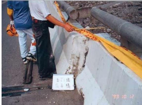
*Figura 1-7. Deslizamiento de la superestructura Puente Shin-Yi. (Hung Lu et al., 2010)*
