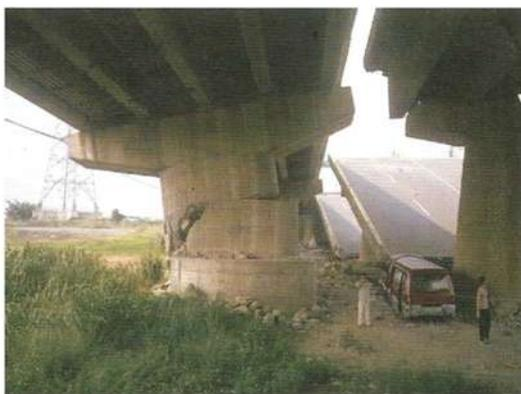
**Figura 1-4. Derrumbe de dos primeros vanos en direccion norte del puente Wu-Shi (Chang et al., 2000)**
