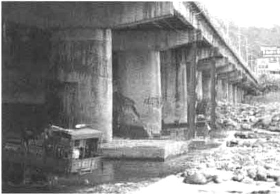
*Figura 1-5. Agrietamientos por flexión y cortante en pila del puente. (Chang et al., 2000)*
