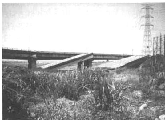
**Figura 1-3. Vanos colapsados y pilares dañados del puente Wu-Shi (Hung Lu et al., 2010)**
