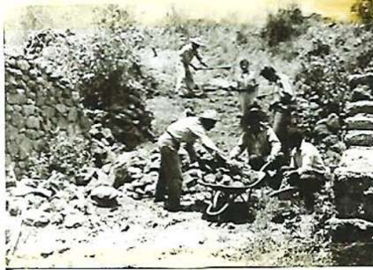
Figura 4.19 La construcción de la vereda principal de Urandén.
