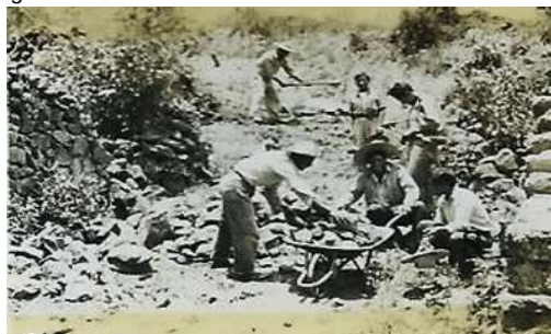
Figura 5.21 Construcción del camino de acceso a la isla.
