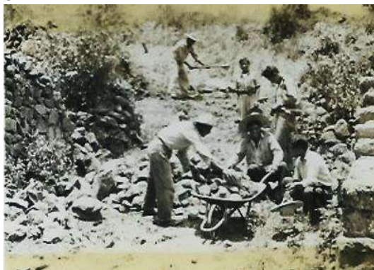
Figura 4.25 Construcción del camino a Urandén.
