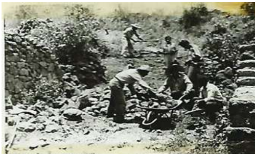
Figura 5.5 La construcción del camino de acceso a Urandén.
