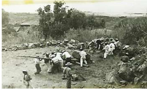
Figura 5.13 Trabajos para el mejoramiento de la cancha de basquetbol.
