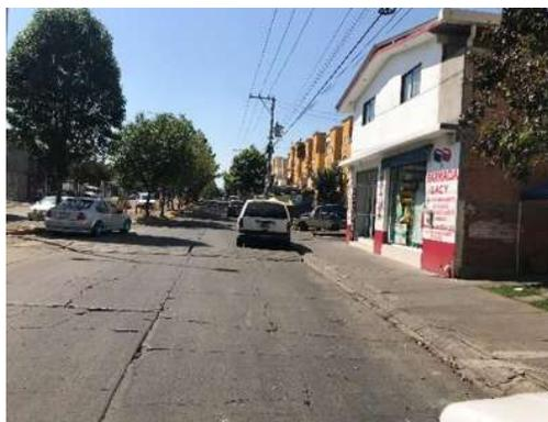
Nota: Pavimento de concreto en mal estado sobre vialidad secundaria.
