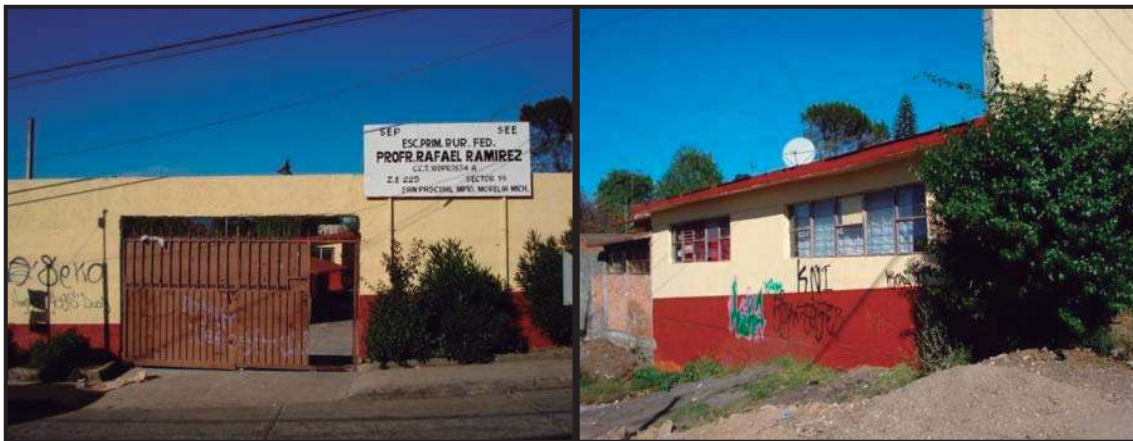
Figura 6. Perímetro de la Escuela Primaria Rural Federal “Profesor Rafael Ramírez” ubicada en San Pascual, Michoacán. Nótese la urbanización solo en el frente de la escuela mientras que en el costado de las instalaciones se puede apreciar la calle sin pavimentar y en condiciones de poca limpieza.
